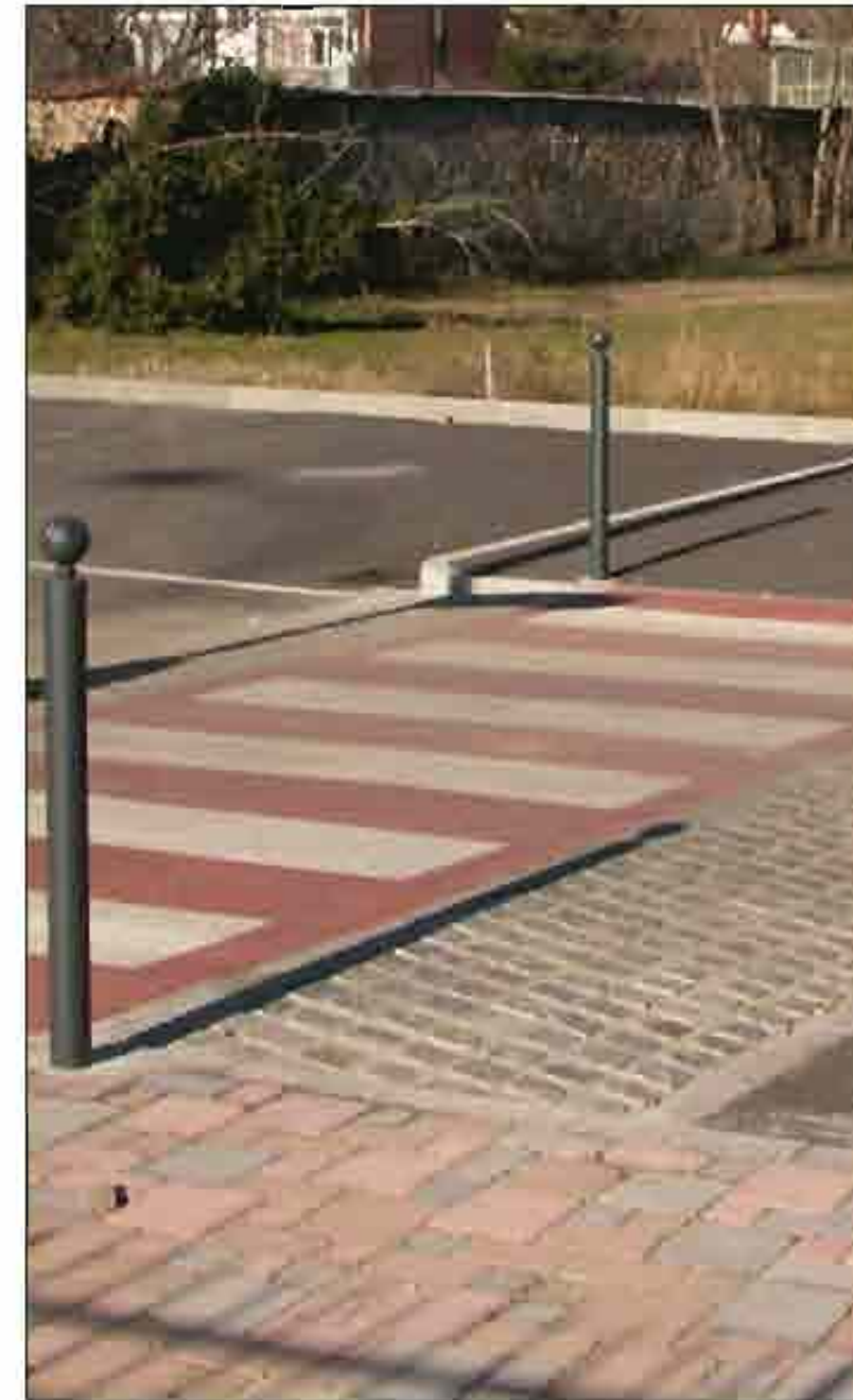
ESEMPIO DI PASSAGGIO PEDONALE RIALZATO
