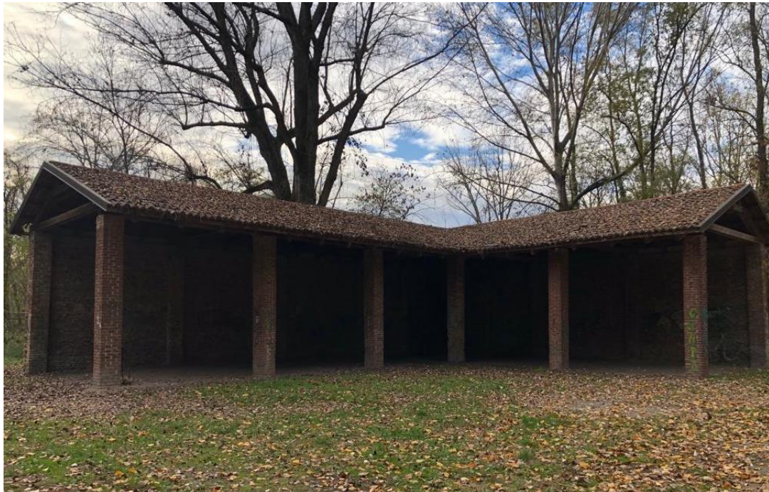
Figura 4 STettoia - foto da sopralluogo
