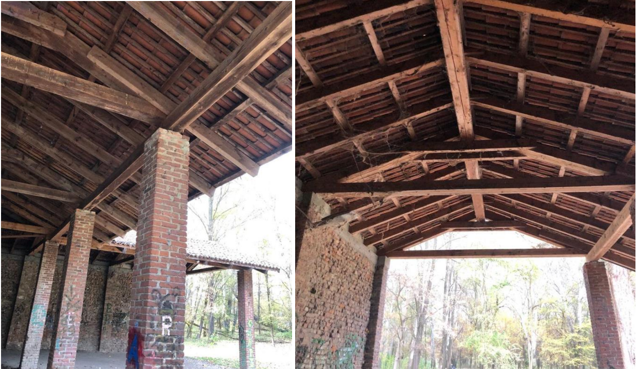
Figura 5 Tettoia - foto da sopralluogo
