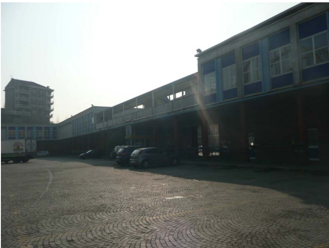
vista cortile interno stabilimento - lato via Filadelfia
