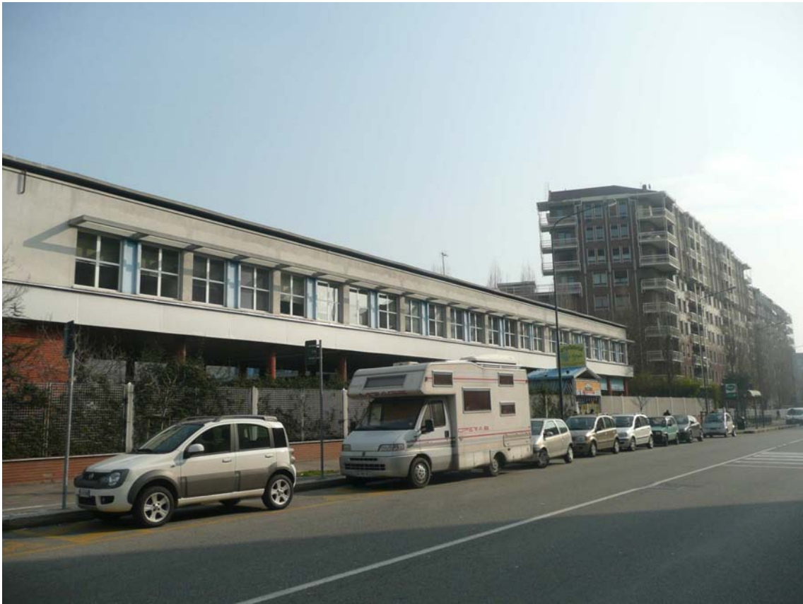
vista lato via Filadelfia
