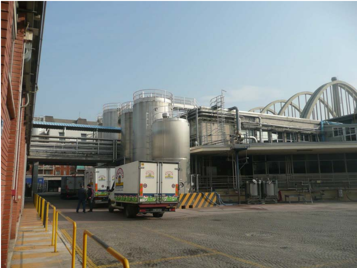
vista cortile interno stabilimento – lato via Lima
