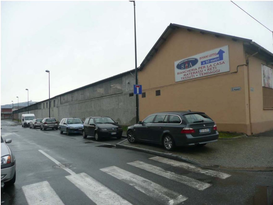
vista frontale lato via Massari angolo via Ala di Stura
