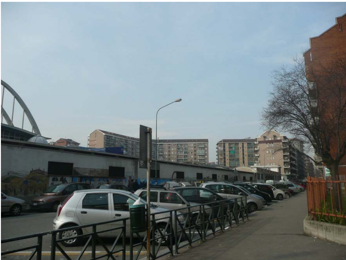
vista lato via Baltimora angolo via Lima
