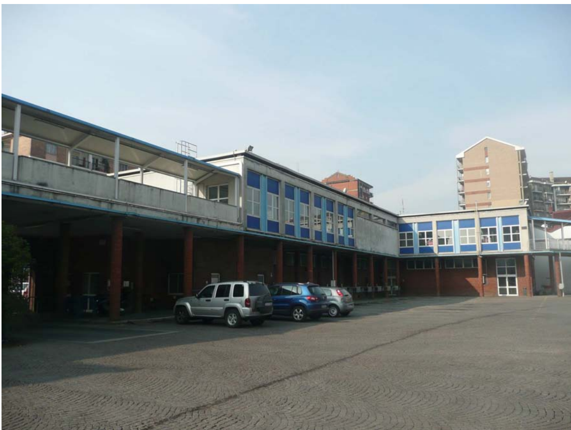
vista cortile interno stabilimento – lato via Filadelfia angolo via Lima
