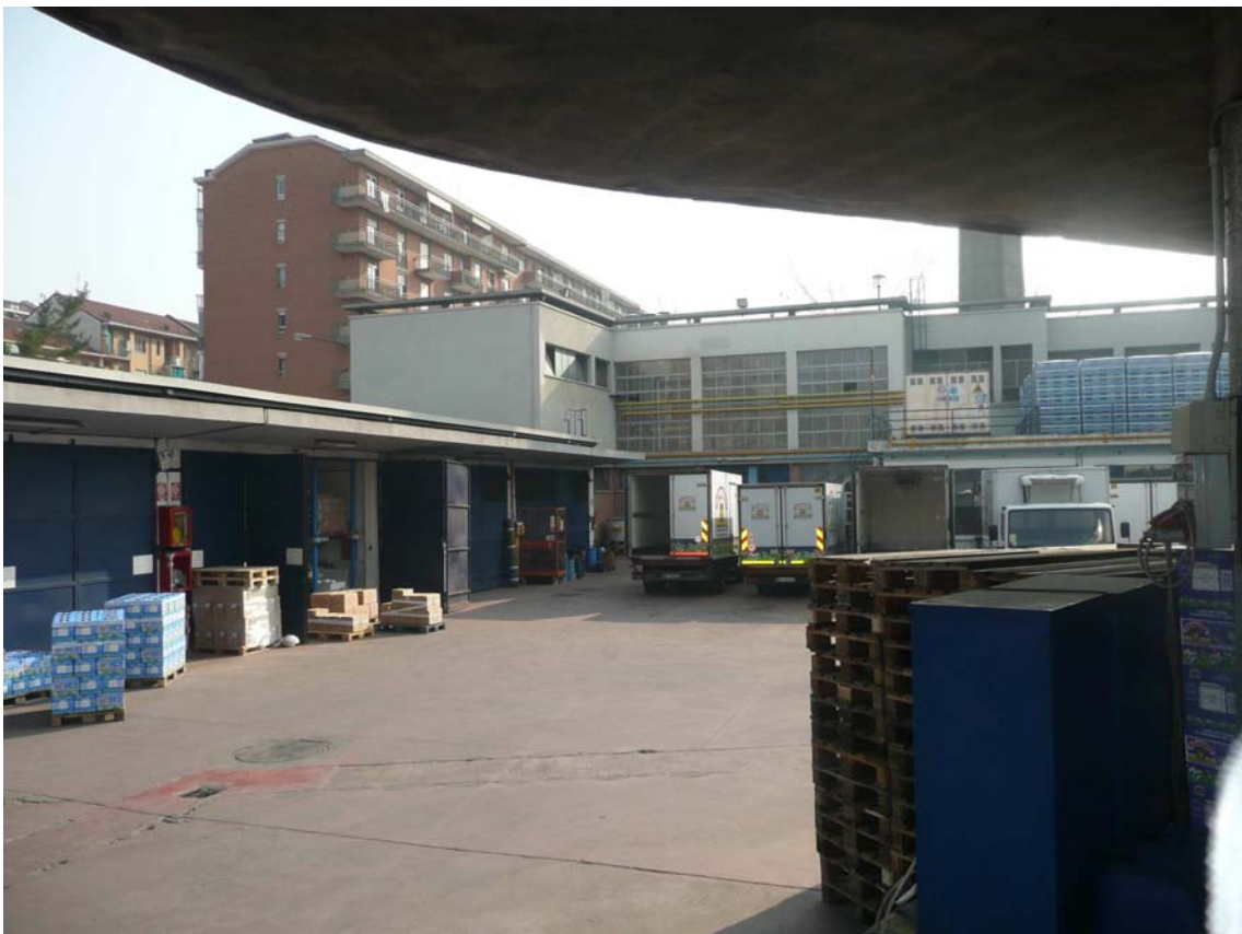
vista cortile interno stabilimento – lato via Baltimora
