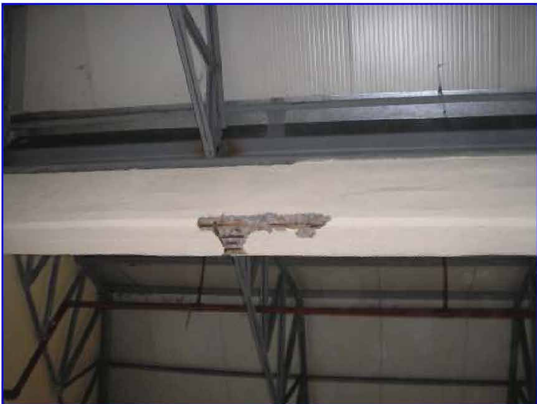
Zona di prelievo del Ferro Fe 1
