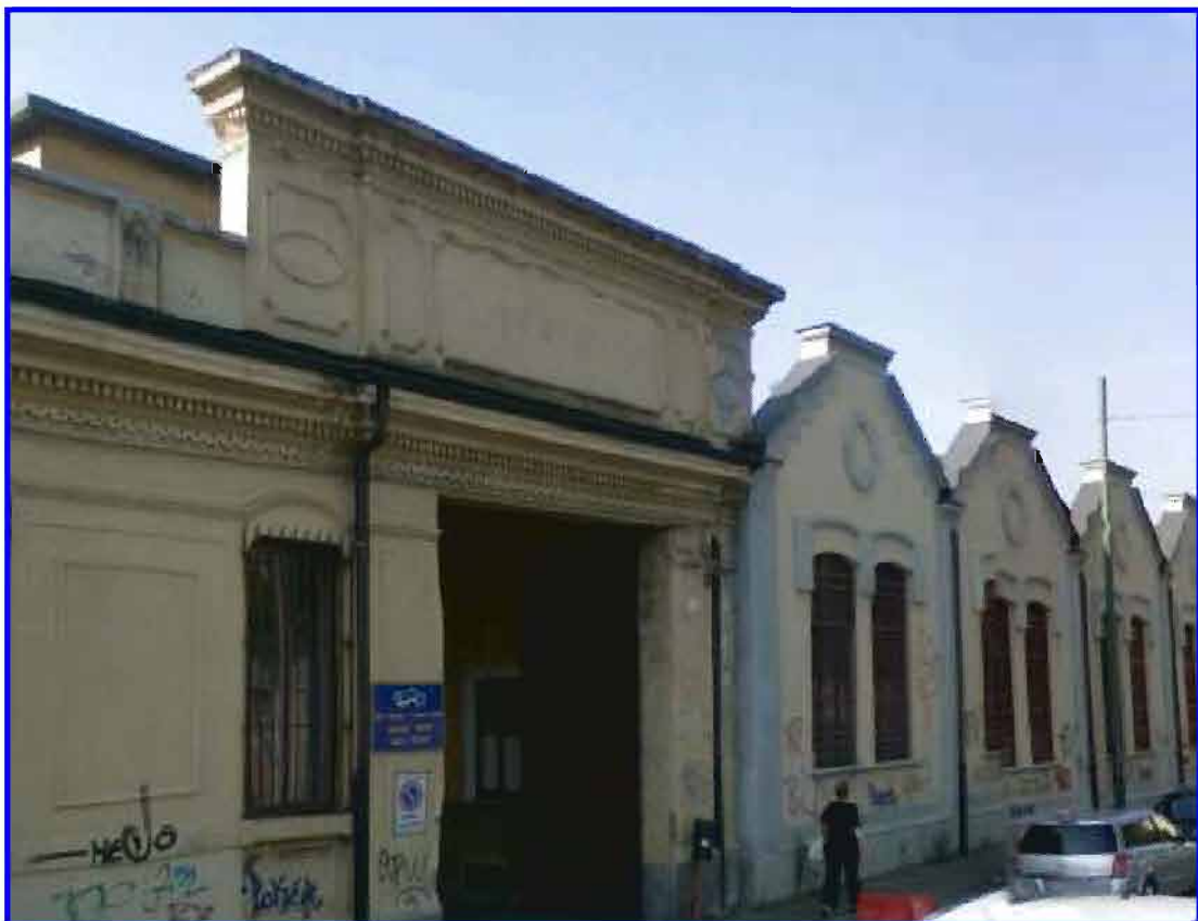
Panoramica del fabbricato
