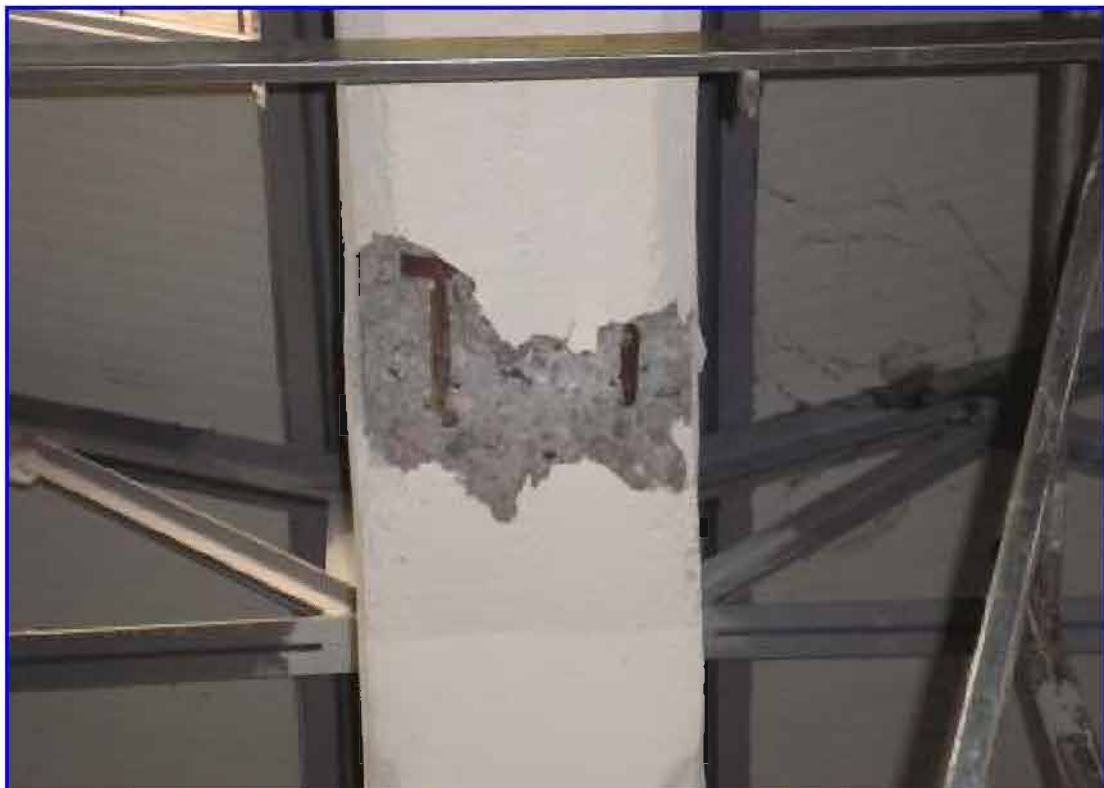
Particolare del sondaggio in corrispondenza dell'appoggio
