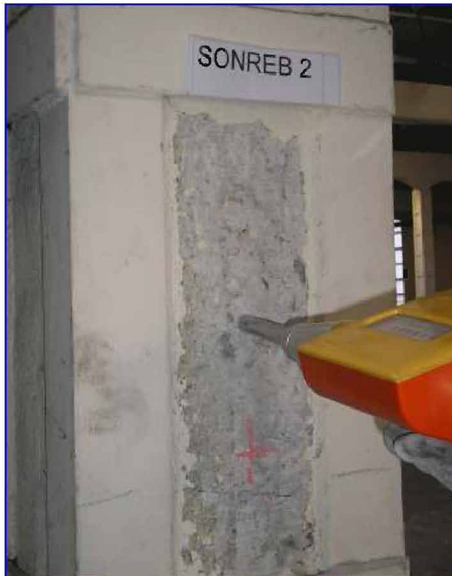
Le battute sclerometriche sul pilastro 2
