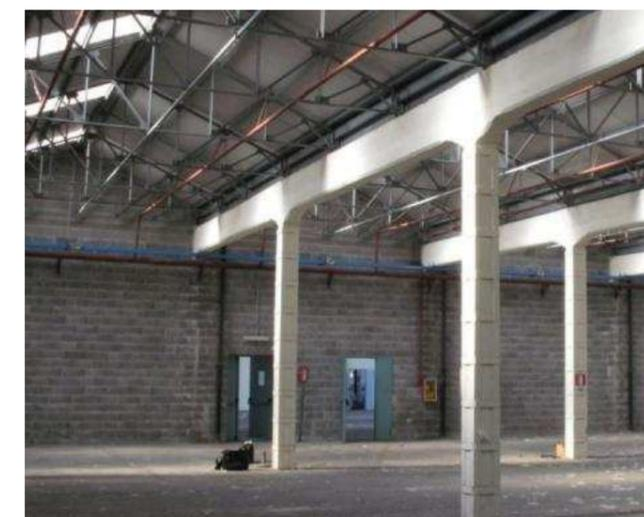
Stato attuale, particolare delle opere di consolidamento mediante cerchiaggio con elementi metallici
