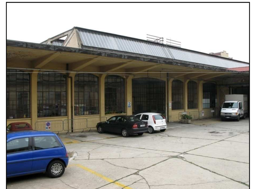
Vista da cortile
