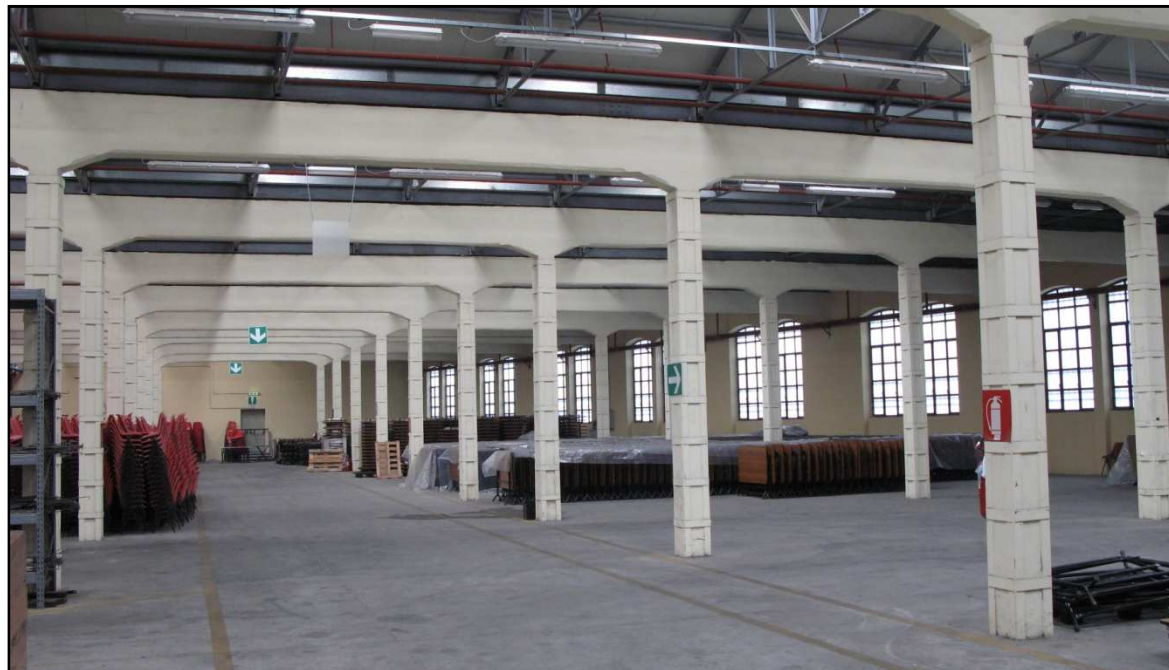
Vista interna dei magazzini
