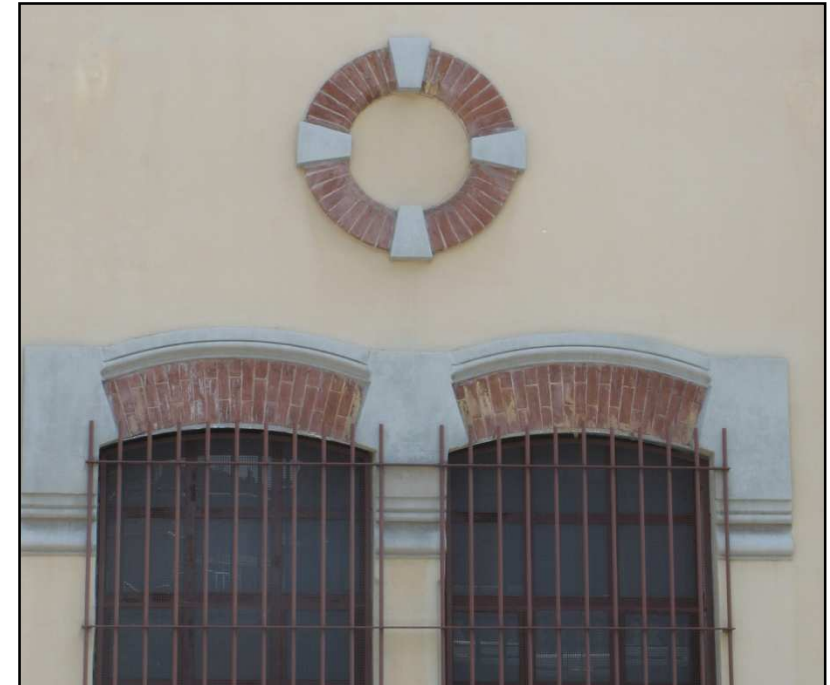
Particolare muro da mantenere su via Revello
