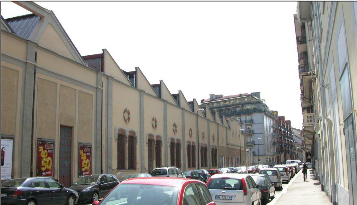
Vista del muro da mantenere su via Revello
