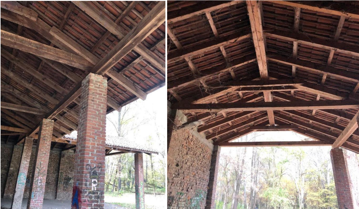
Figura 5 Tettoia - foto da sopralluogo
