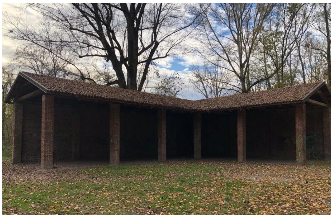
Figura 4 Tettoia - foto da sopralluogo
