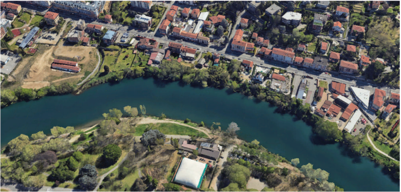
Area oggetto di intervento
