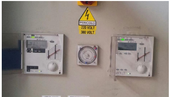
Centraline di termoregolazione
