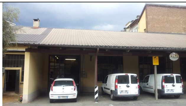
Immagine delle coperture in lamiera
