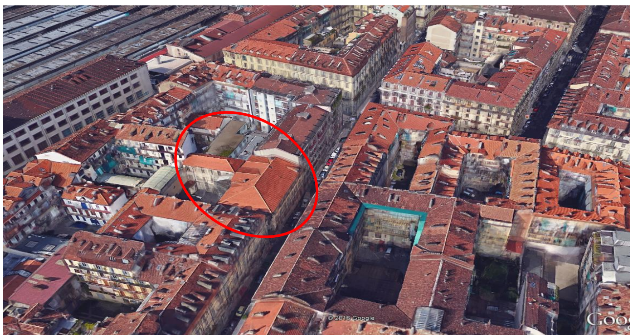
Inquadramento aerofotogrammetrico dell'edificio oggetto di analisi
