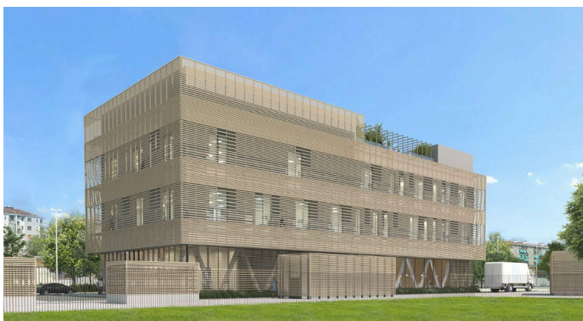
Figura 1. Deposito Officina Rebaudengo
