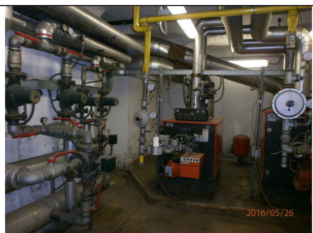
Vista su generatori e distribuzione
