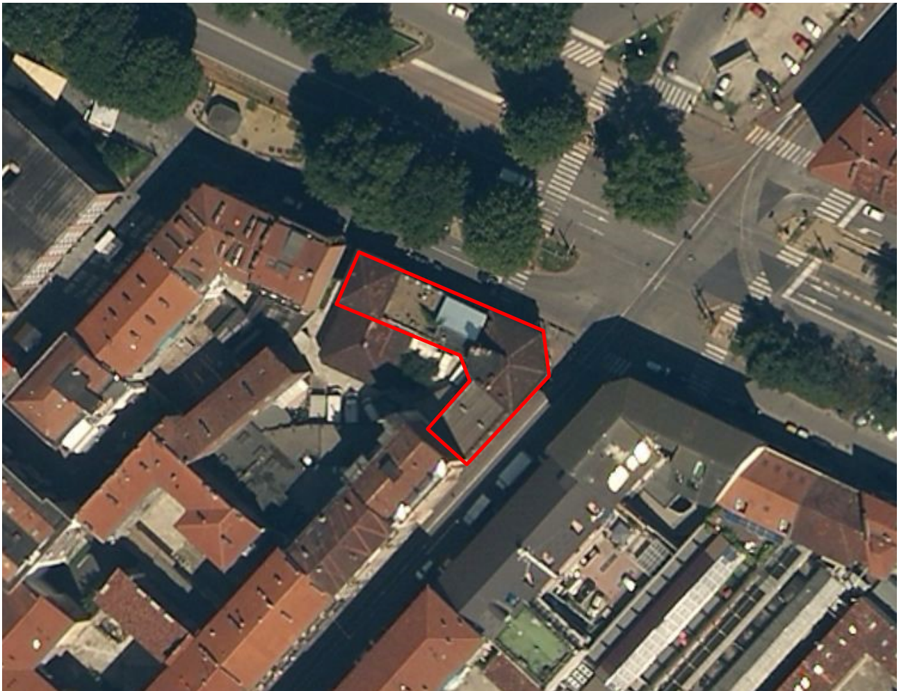
Figura 2 - Vista aerea dell'edificio oggetto di analisi
