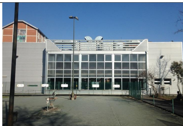
Prospetto ingresso principale sud
