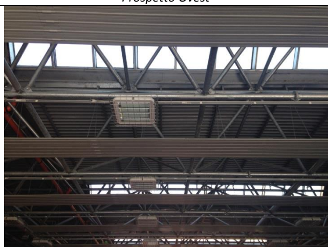
Solaio di copertura con lucernari
