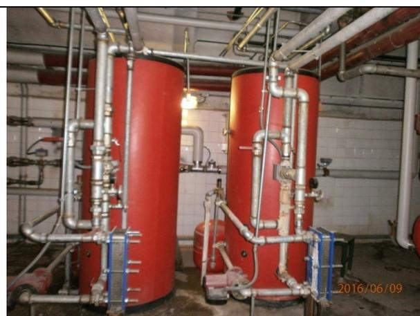
*Accumulatori acqua calda (1000 l/cad.) alimentati da scambiatori a piastre*
