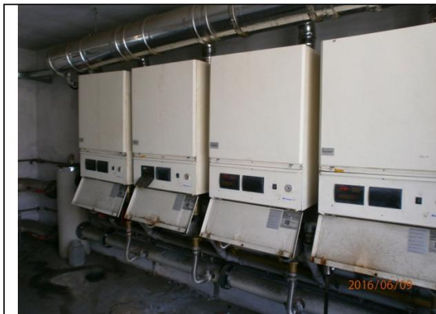
*Generatori esistenti, installati in locale tecnico nel sottotetto*
