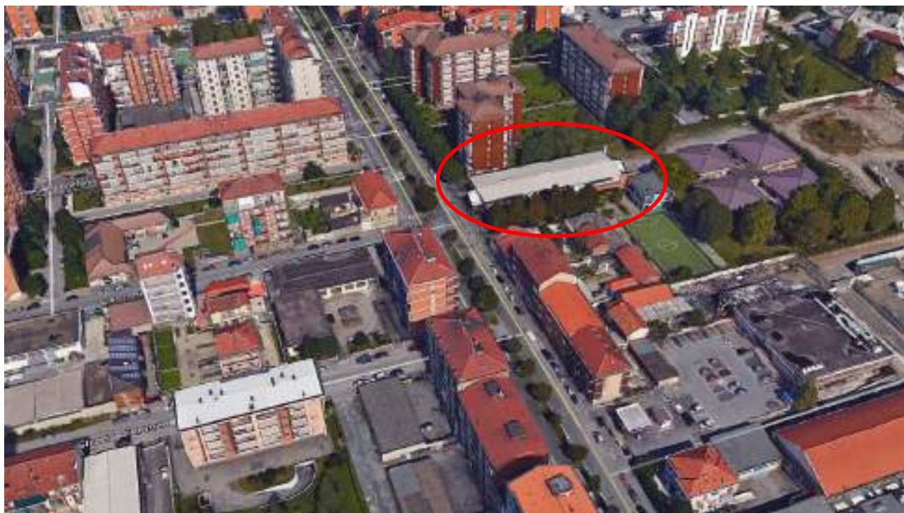
Inquadramento aerofotogrammetrico dell'edificio oggetto di analisi
