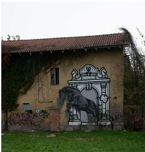
Affresco su edificio principale, foto da sopralluogo
