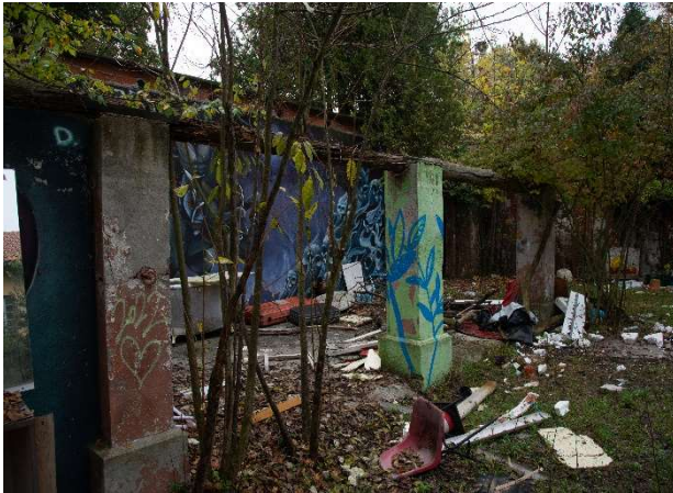
Tettoia da demolire, foto da sopralluogo
