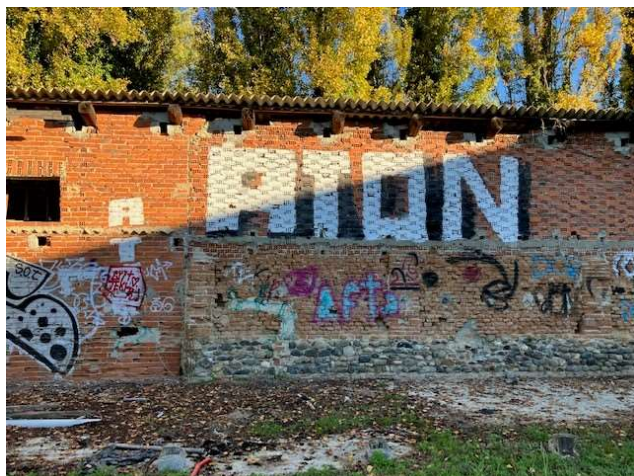
Dettagli delle murature, foto da sopralluogo
