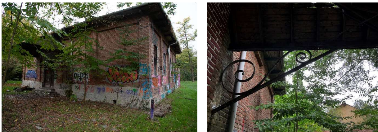
Casa Reale (edificio F), foto da sopralluogo
