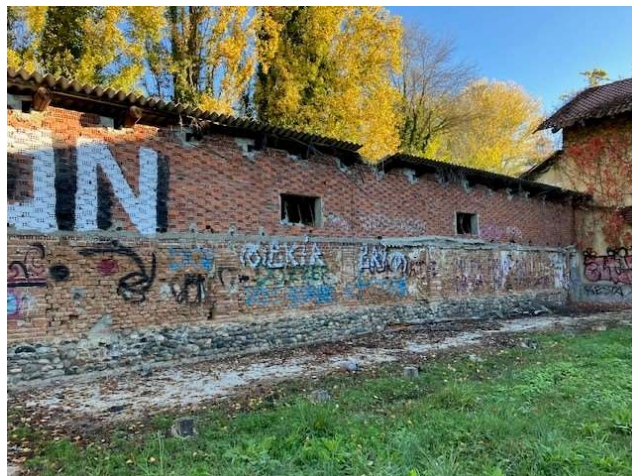
Dettagli delle murature, foto da sopralluogo
