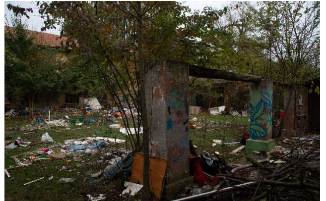
Tettoia da demolire, foto da sopralluogo
