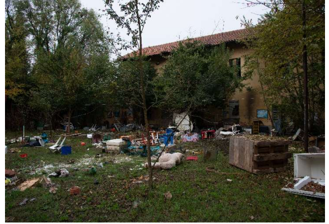
Edificio principale verso corte interna, foto da sopralluogo
