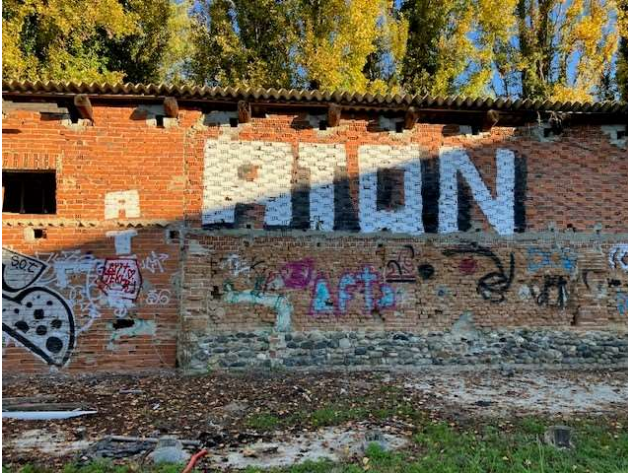
Dettagli delle murature, foto da sopralluogo
