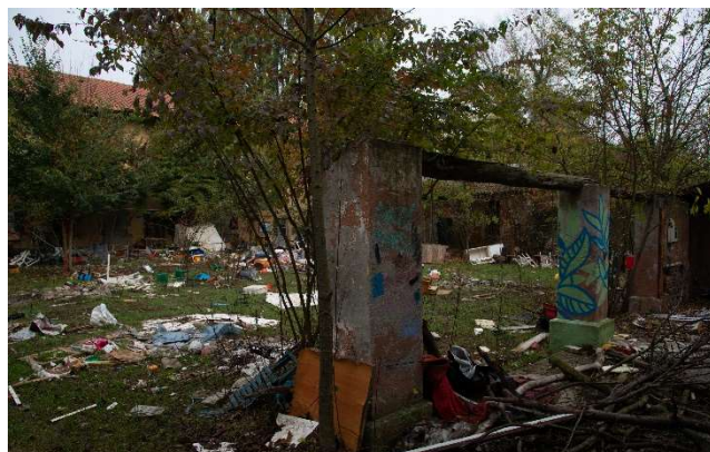
Tettoia da demolire, foto da sopralluogo
