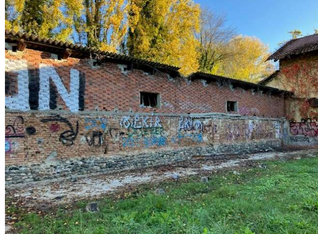
Dettagli delle murature, foto da sopralluogo
