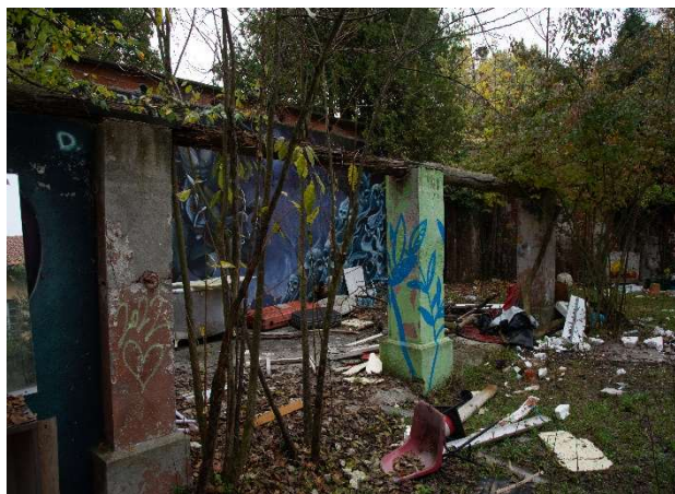
Tettoia da demolire, foto da sopralluogo
