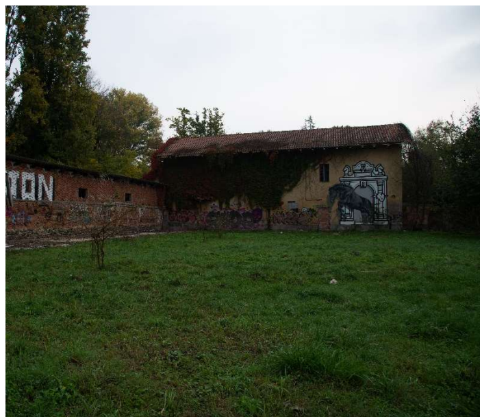
Facciata verso il fiume, foto da sopralluogo
