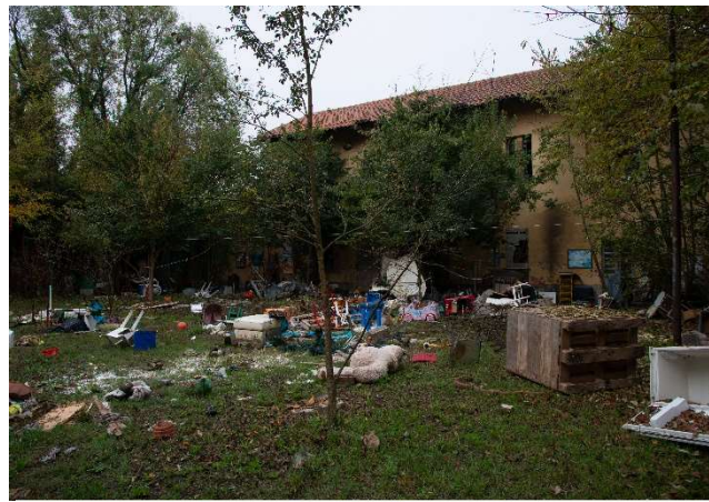
Edificio principale verso corte interna, foto da sopralluogo
