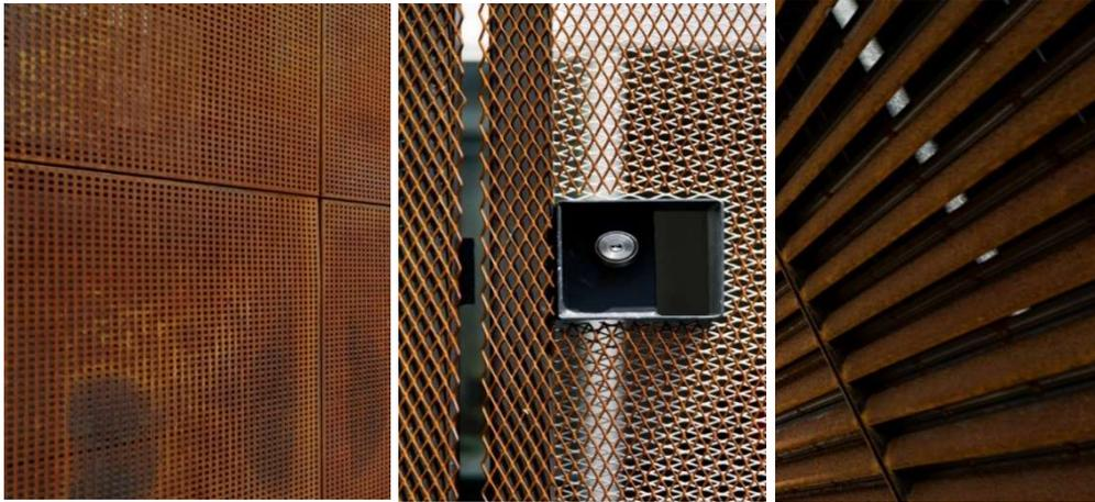
*Acciaio Cor-Ten in pannelli forati    Acciaio Cor-Ten in reti    Acciaio Cor-Ten in lamelle orientate*
