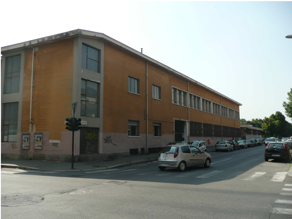
Vista lato via Marsigli ang. via Bardonecchia
