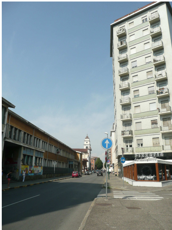
Vista imm.le lato via Bardonecchia
