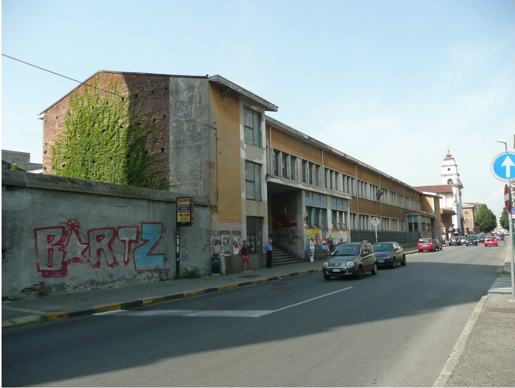
Vista imm.le lato via Bardonecchia 151
