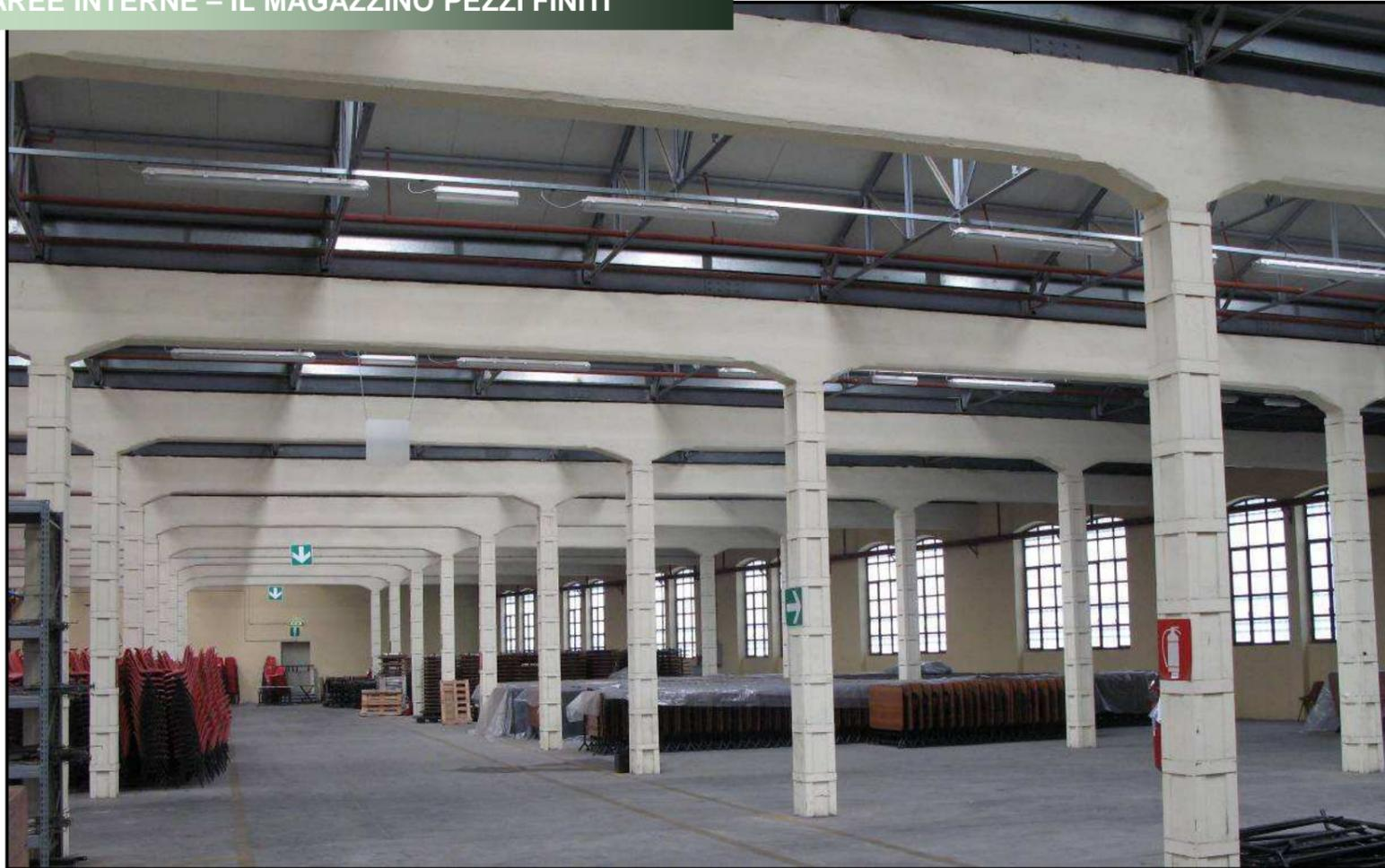
Vista interna del "Magazzino Pezzi Finiti": in evidenza i rinforzi e le cerchiature delle strutture in c.a.
