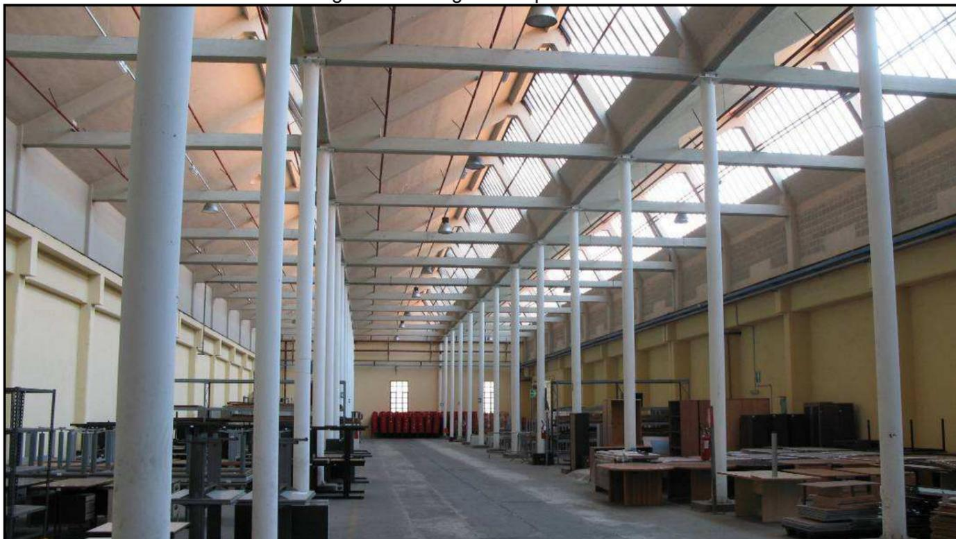
Vista verso la facciata interna verso via Revello. In evidenza le recenti colonne metalliche di rinforzo strutturale
