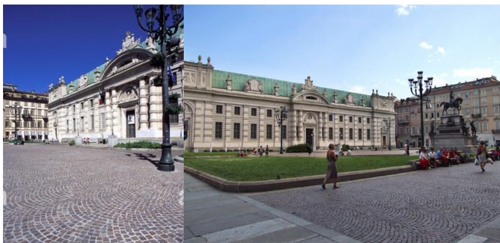
Figura 14. La pavimentazione in porfido e i marciapiedi in pietra di luserna
