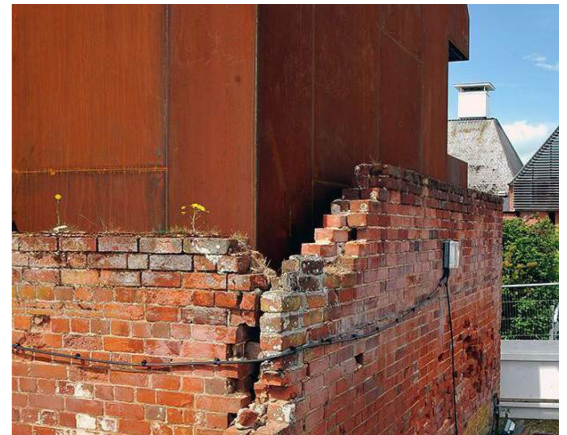
trattamento pareti esistenti
