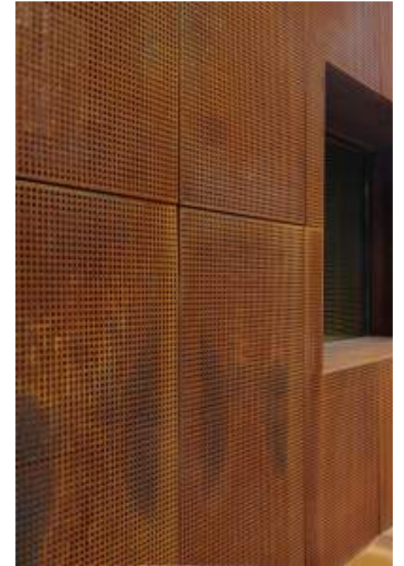
riferimenti delle varie tipologie di rivestimenti in Cor-Ten.
