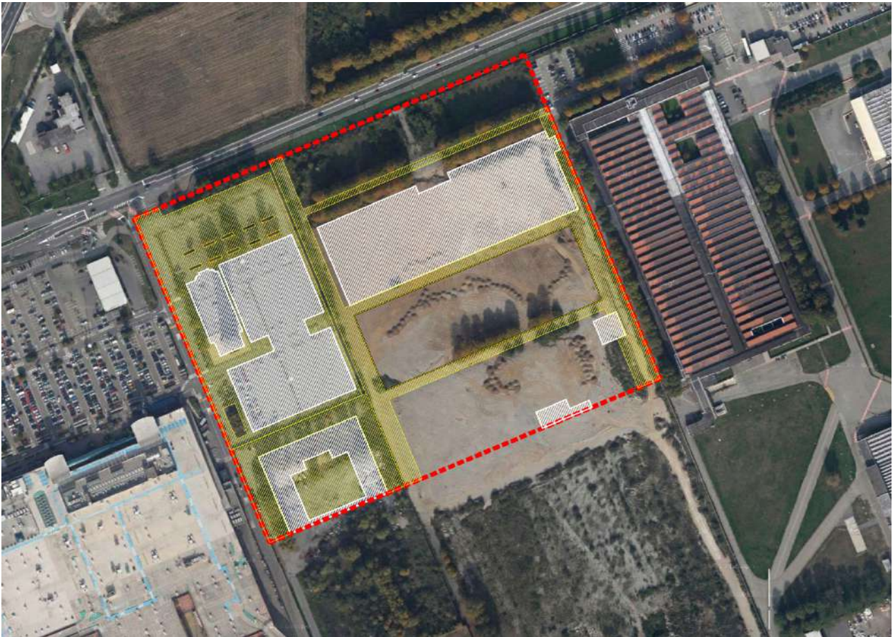
Figura 12 Aree compromesse nella edificazione più recente
