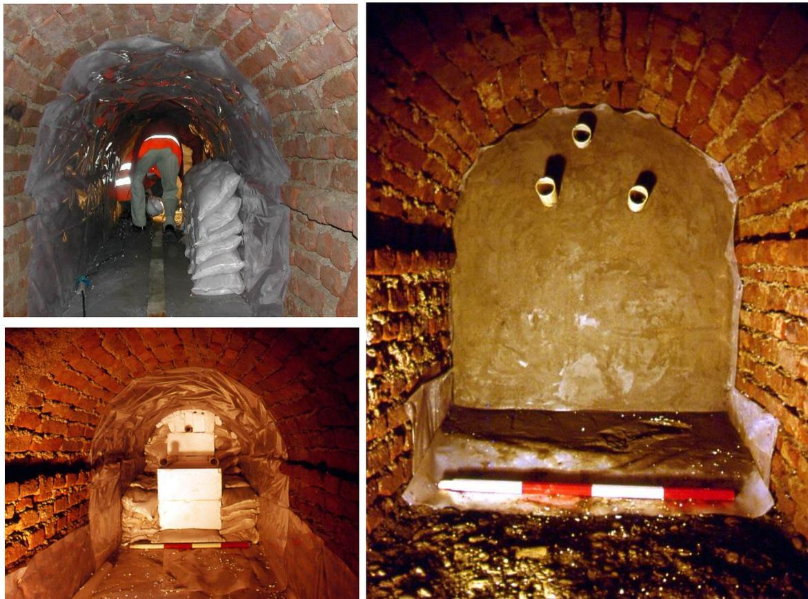
**Figura 13. Interventi di protezione sulle Gallerie della Cittadella durante la realizzazione della linea 1 della Metropolitana di Torino (2004-2005).**
