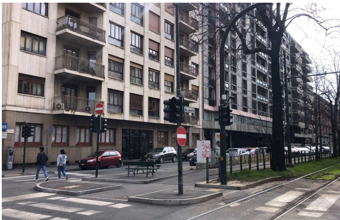
Figura 91. Stazione Pastrengo – Stato di fatto – vista verso sud
