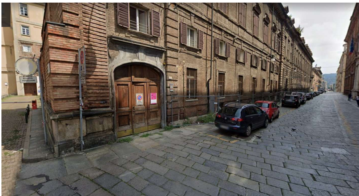
Figura 65. Pozzo Carlo Alberto – Stato di fatto dell'area dove verrà collocata la griglia
