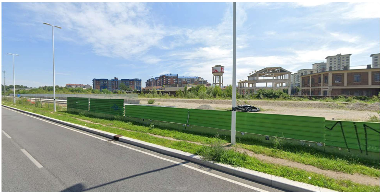
Figura 30. Area di insediamento del deposito – Stato di fatto – vista da sud-est
