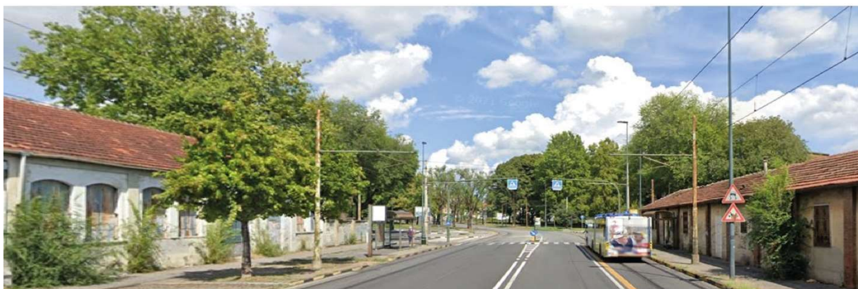
Figura 49. Stazione Cimarosa/Tabacchi – Stato di fatto – Vista da sud
