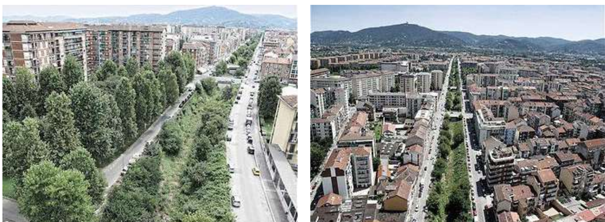
Figura 38. Area del trincerone – Viste a volo d'uccello dello stato dei luoghi
