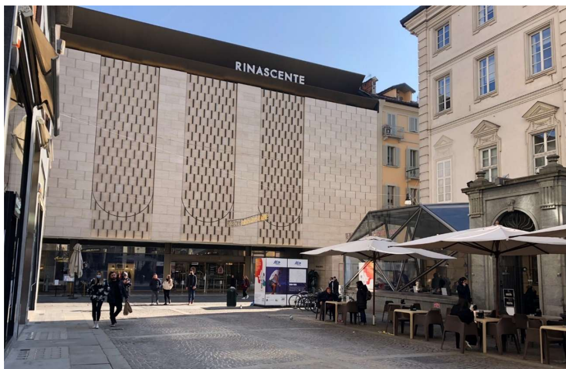
Figura 80. Pozzo Porta Nuova – Stato di fatto – Vista verso via Lagrange
