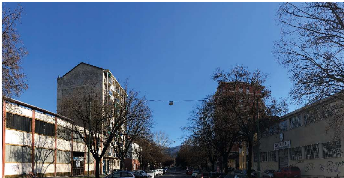
Figura 57. Stazione Verona – Stato di fatto su corso Verona – Vista verso sud-est
