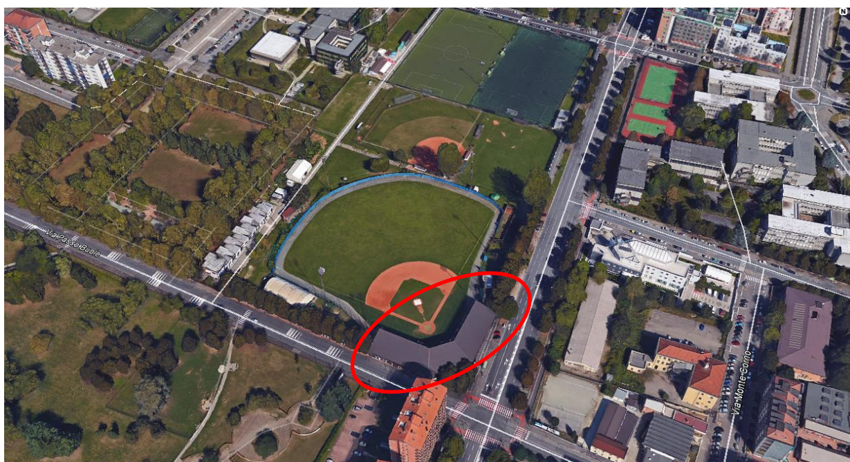
Inquadramento aerofotogrammetrico dell'edificio oggetto di analisi
