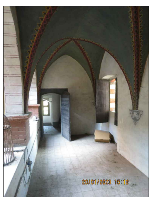
Loggiato cortile di Avigliana 110 e 111
