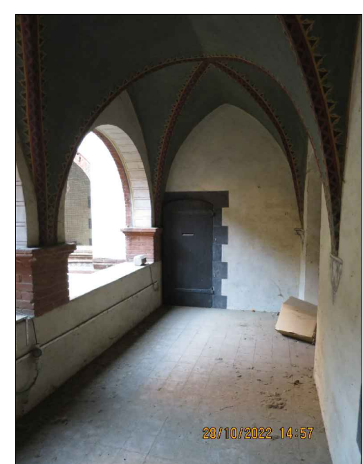
Loggiato cortile di Avigliana 110 e 111
