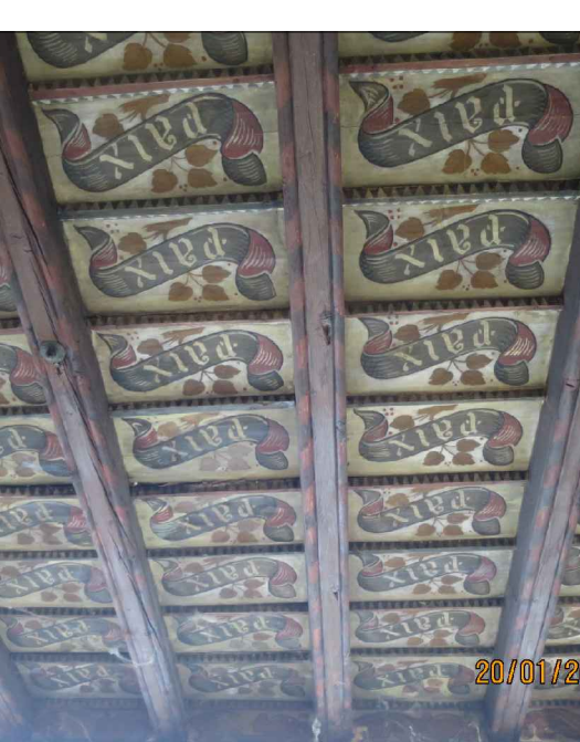
Casa Borgofranco 114. Si evidenzia in ROSSO il perimetro oggetto dello "strappo"
