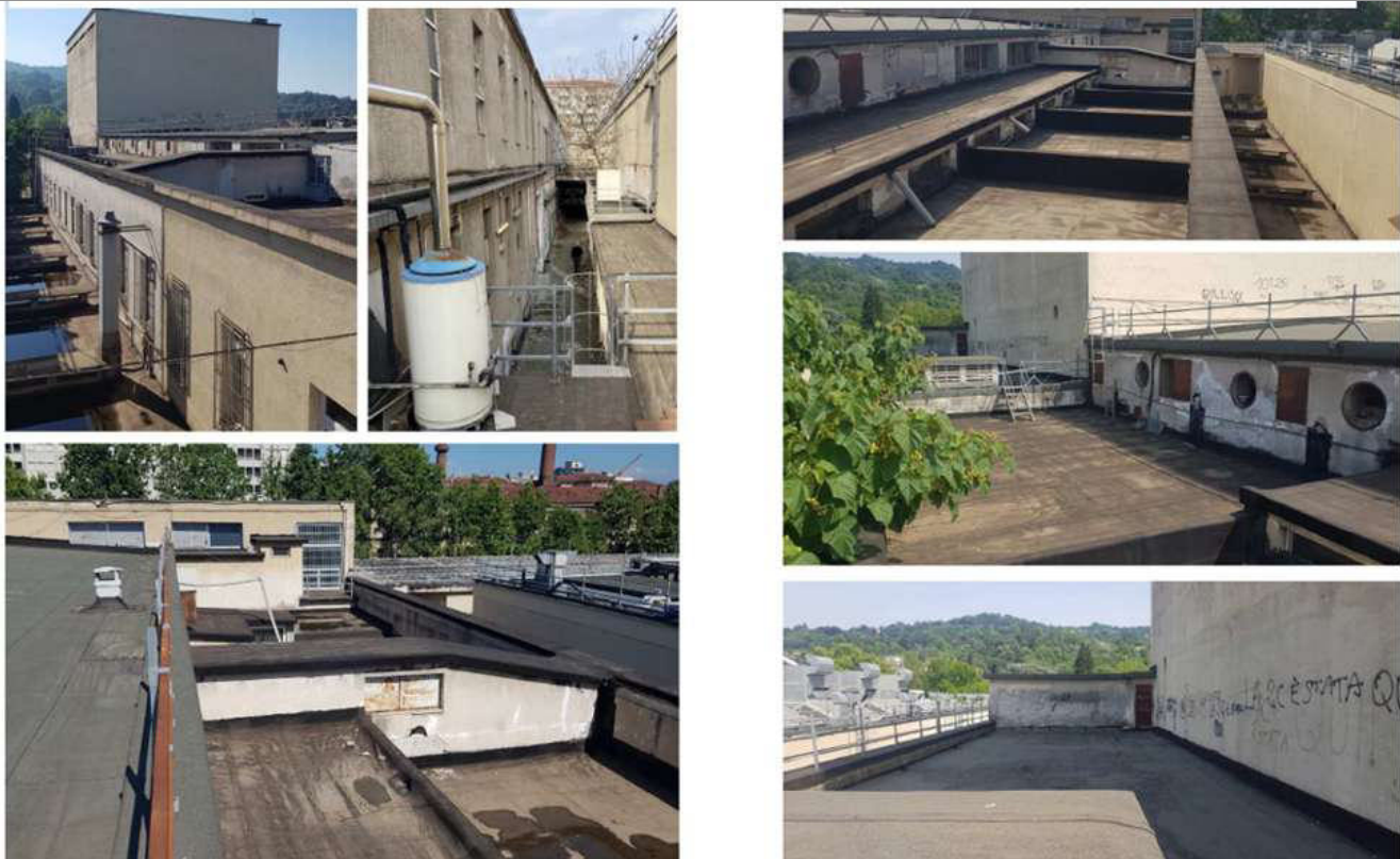
Foto dello stato di fatto: viste di dettaglio delle coperture delle maniche laterali
