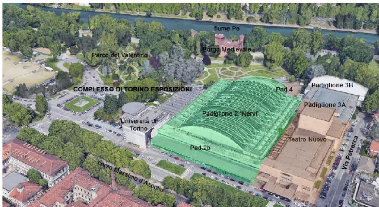
Figura 2 – Vista aerea del Complesso di Torino Esposizioni
