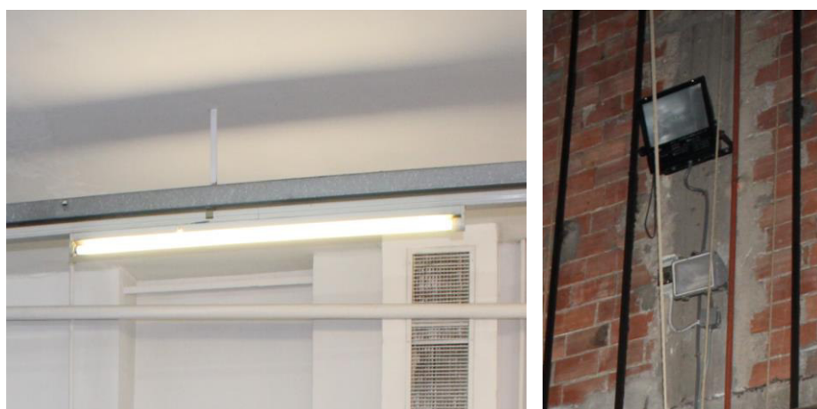
Figura 23 – Apparecchio illuminante a fluorescenza (a sinistra) e di tipo alogeno (a destra)
