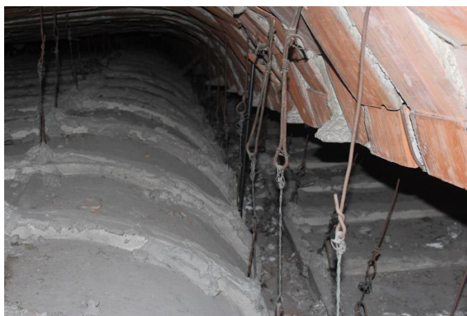
Figura 15 – Vista dall'interno della doppia struttura costituente la copertura del blocco centrale
