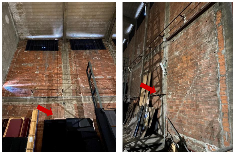
Figura 11 – Parete perimetrale della torre scenica con individuazione delle strutture portanti a vista
