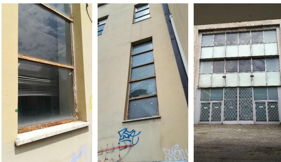
Figura 13 – Serramenti esterni con telaio metallico e vetro singolo
