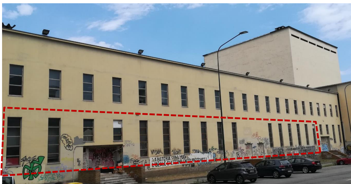
Figura 51 – Individuazione dei serramenti attualmente tamponati internamente (sala Valentino 1)
