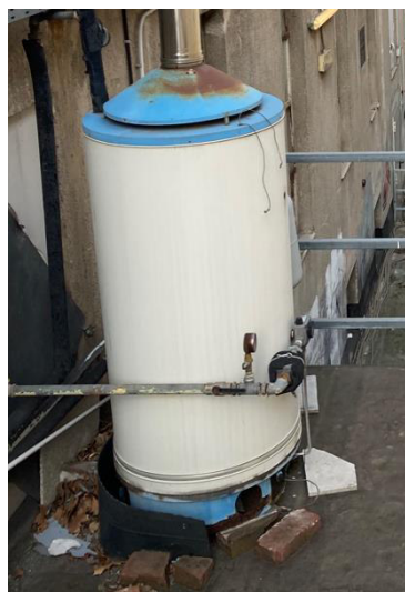
Figura 21 – Sistema di produzione dell’acqua calda sanitaria
