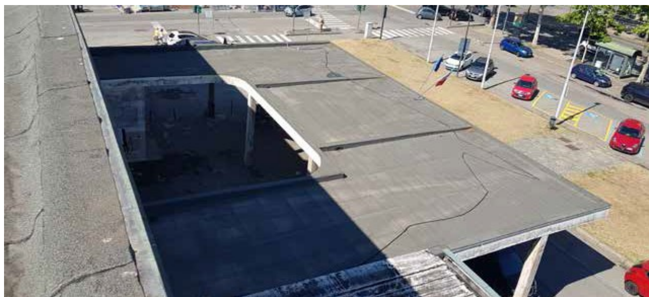
Foto 20: Copertura lato Corso Massimo d'Azzeglio
