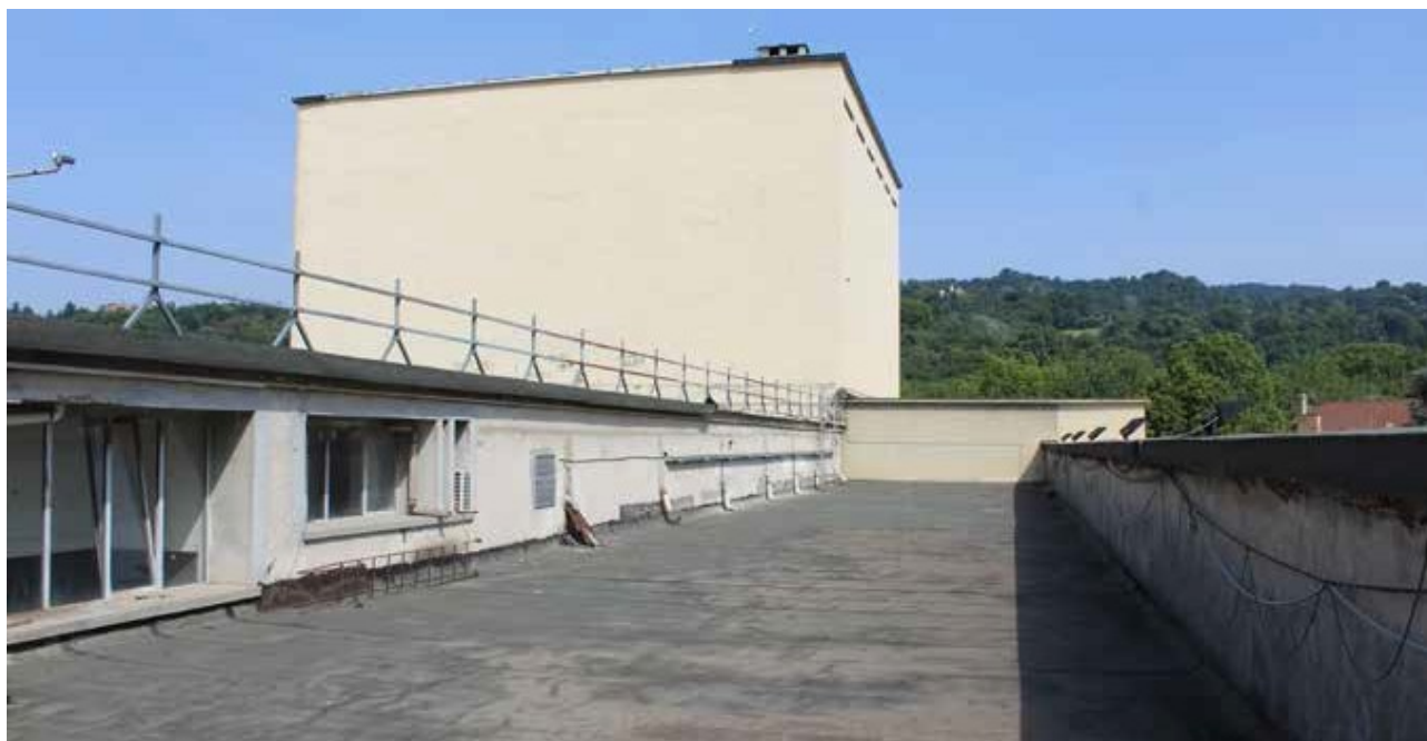
Foto 23: Copertura lato Via Francesco Petrarca
