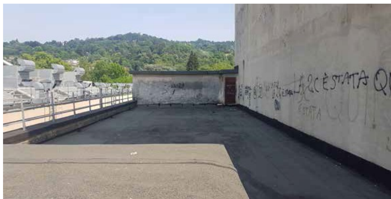
Foto 24: Copertura tra Padiglione 2 e Teatro
