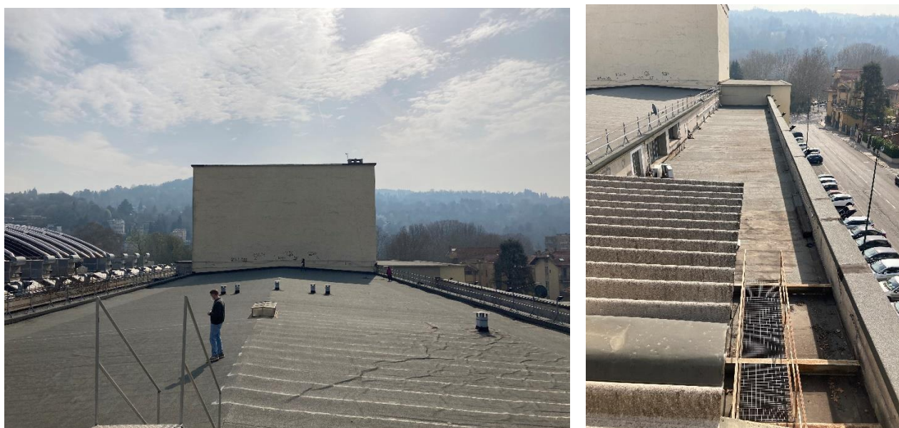
Figura 12 - 13: Coperture di Teatro Nuovo
