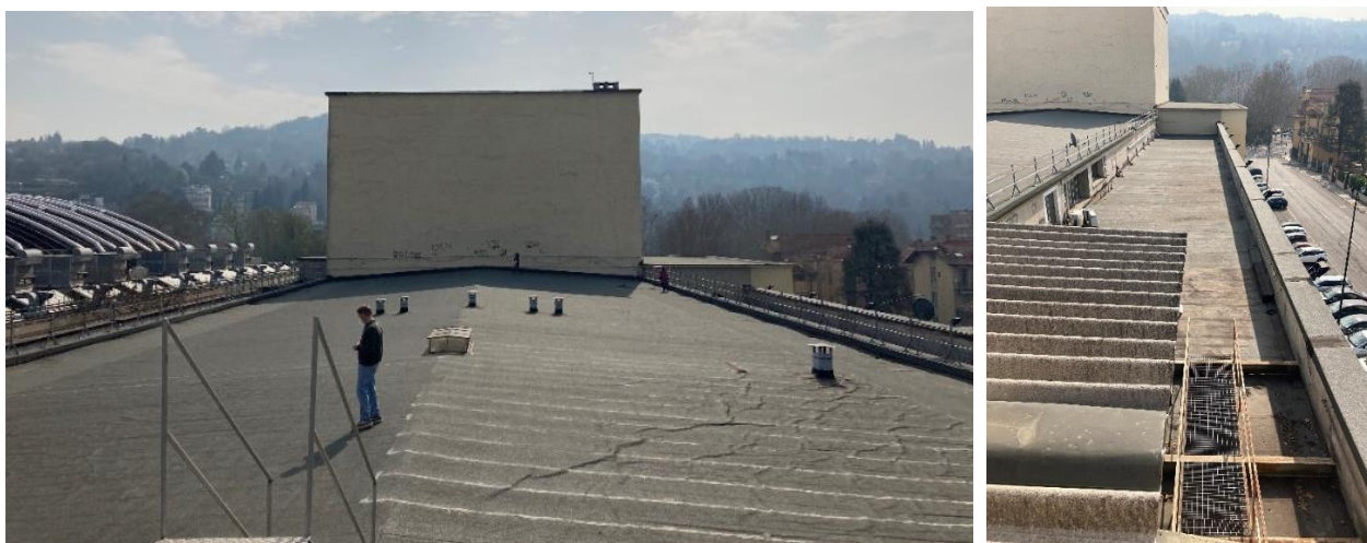
Figura 22 - Coperture di Teatro Nuovo: su Corpo Centrale e su Manica Laterale Petrarca
