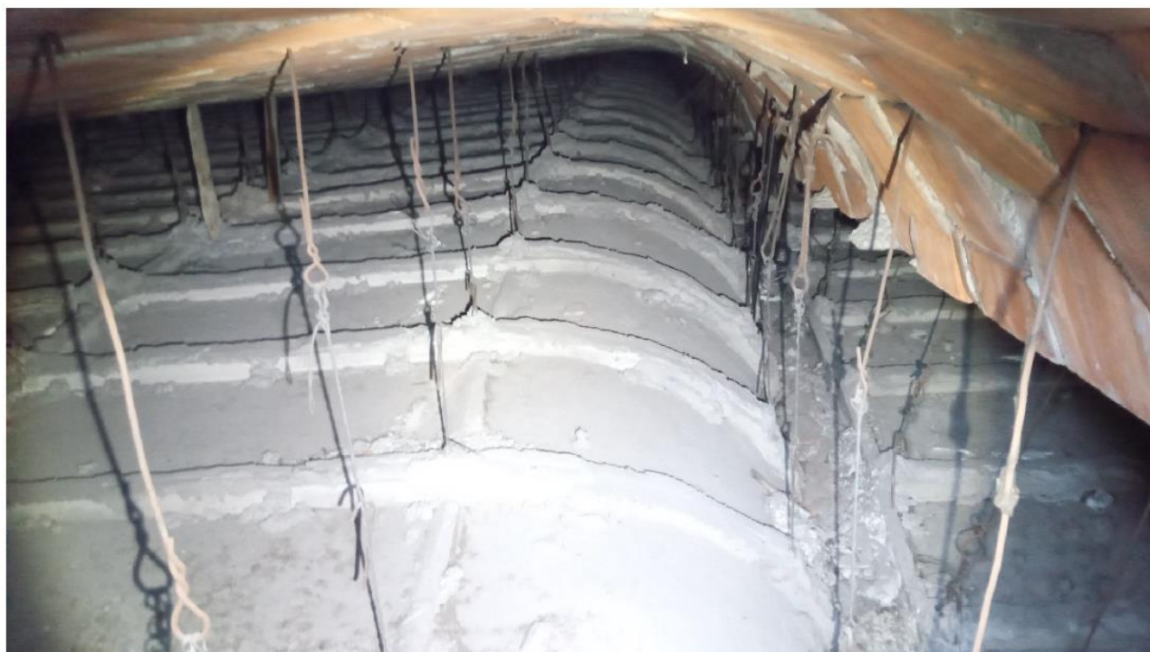
Figura 16: Sala principale – Sistema di appensione del plafone acustico
