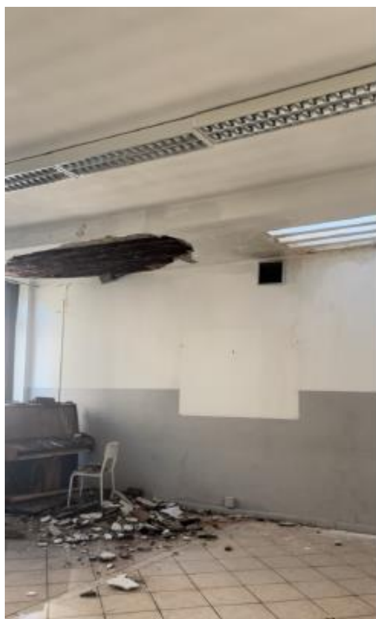
Figura 27 - Maggio 2023 – Sfondellamento solaio di copertura e comparsa di deformazioni nel solaio di copertura (saletta e corridoio)
