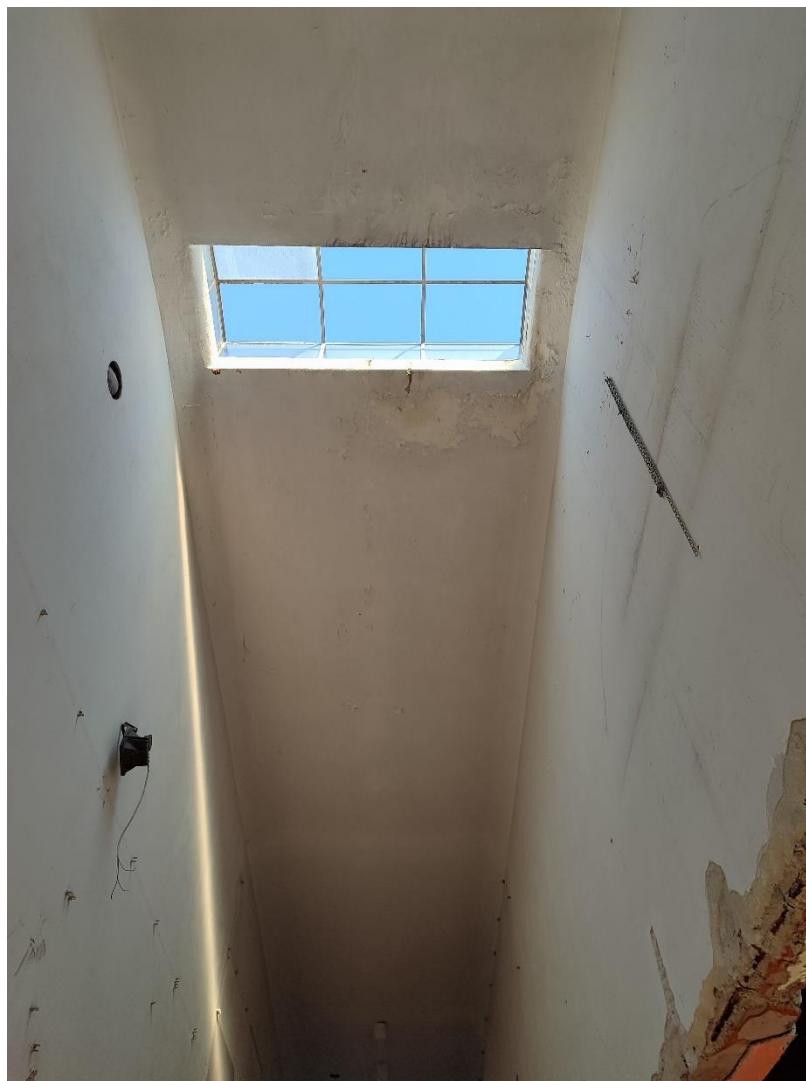
Figura 4 vista interna del lucernario esistente collocato fra le due travi da 3.70 rinvenute durante le prime demolizioni.
