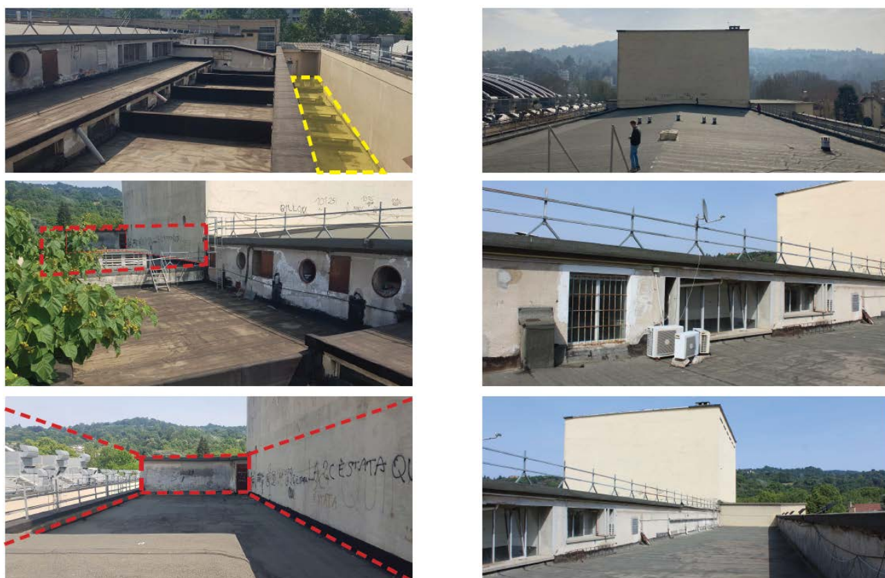
Viste delle coperture delle sala e delle maniche laterali: lato biblioteca (sx) e lato via Petrarca (dx)
