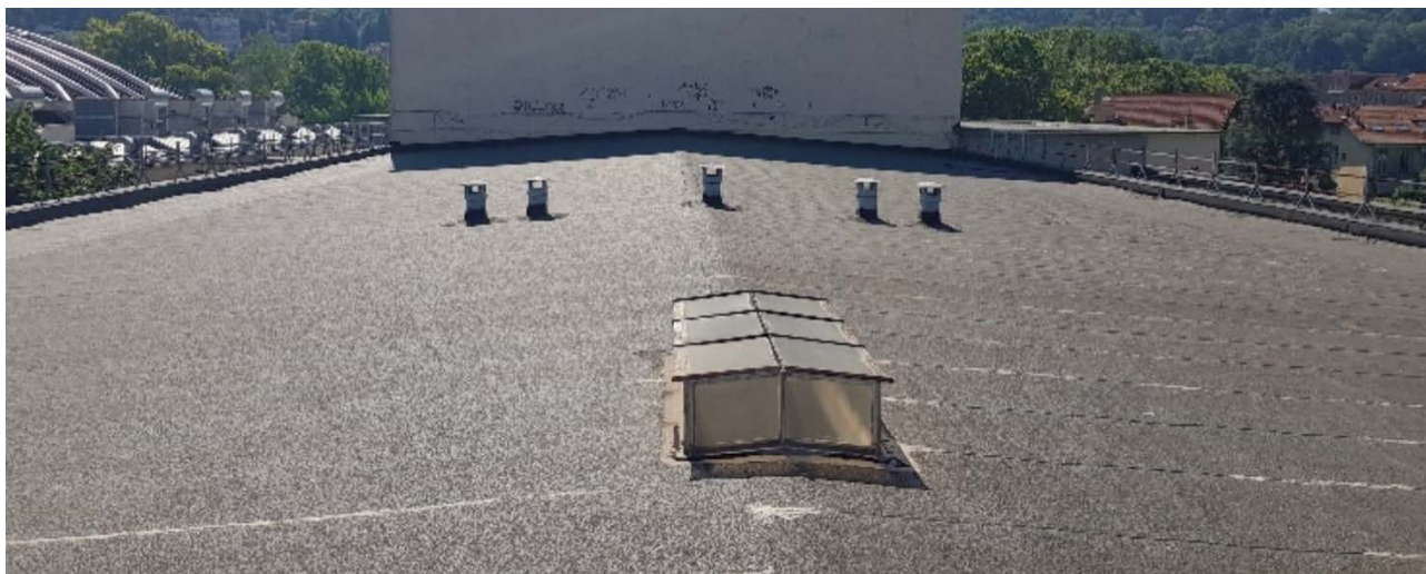
Foto copertura fascia centrale dell'edificio (9)
