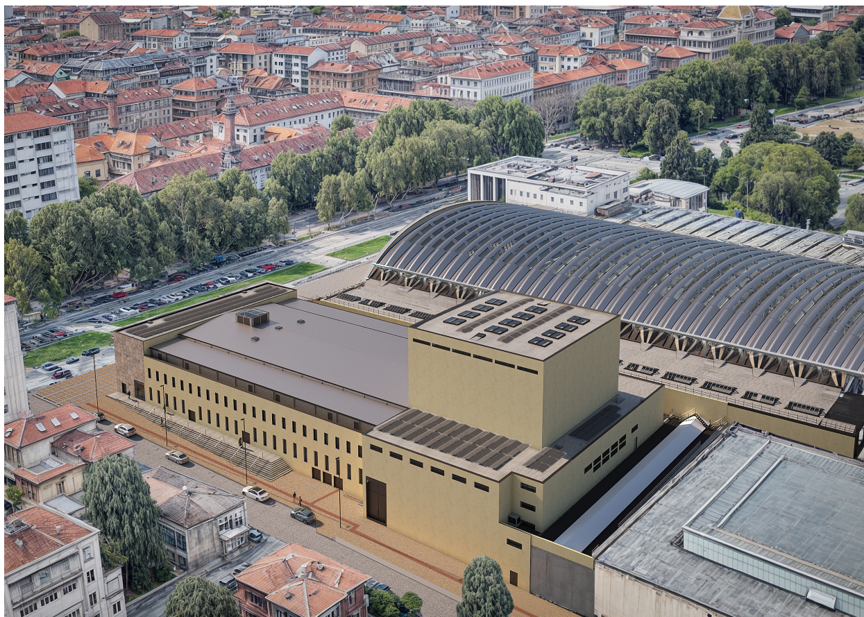
Figura 1 sistemazione esterna su via Petrarca con l'inserimento della pavimentazione tattile (LOGES).
