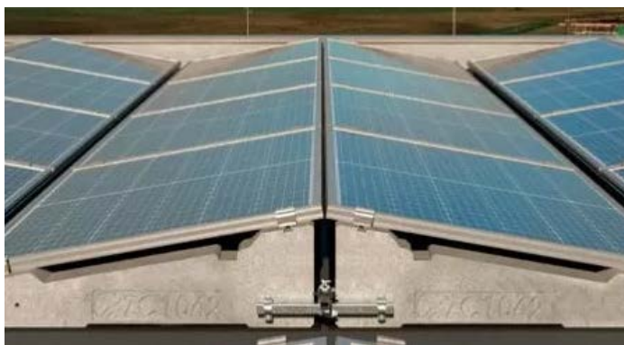
Tipologia con disposizione a falde inclinate adottata
