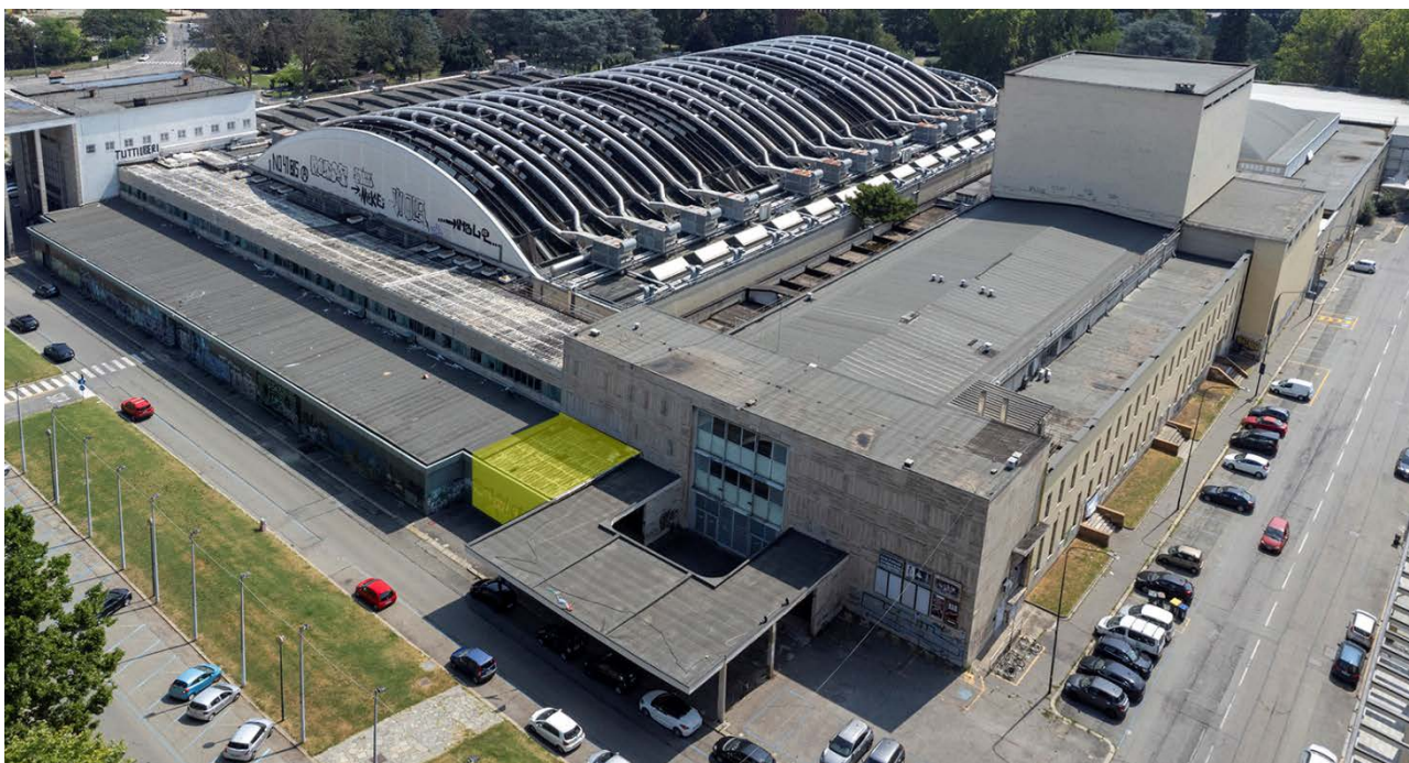
Foto del complesso Torino Esposizioni, fronte su corso Massimo d'Azeglio-avancorpo teatro da demolire colorato in giallo
