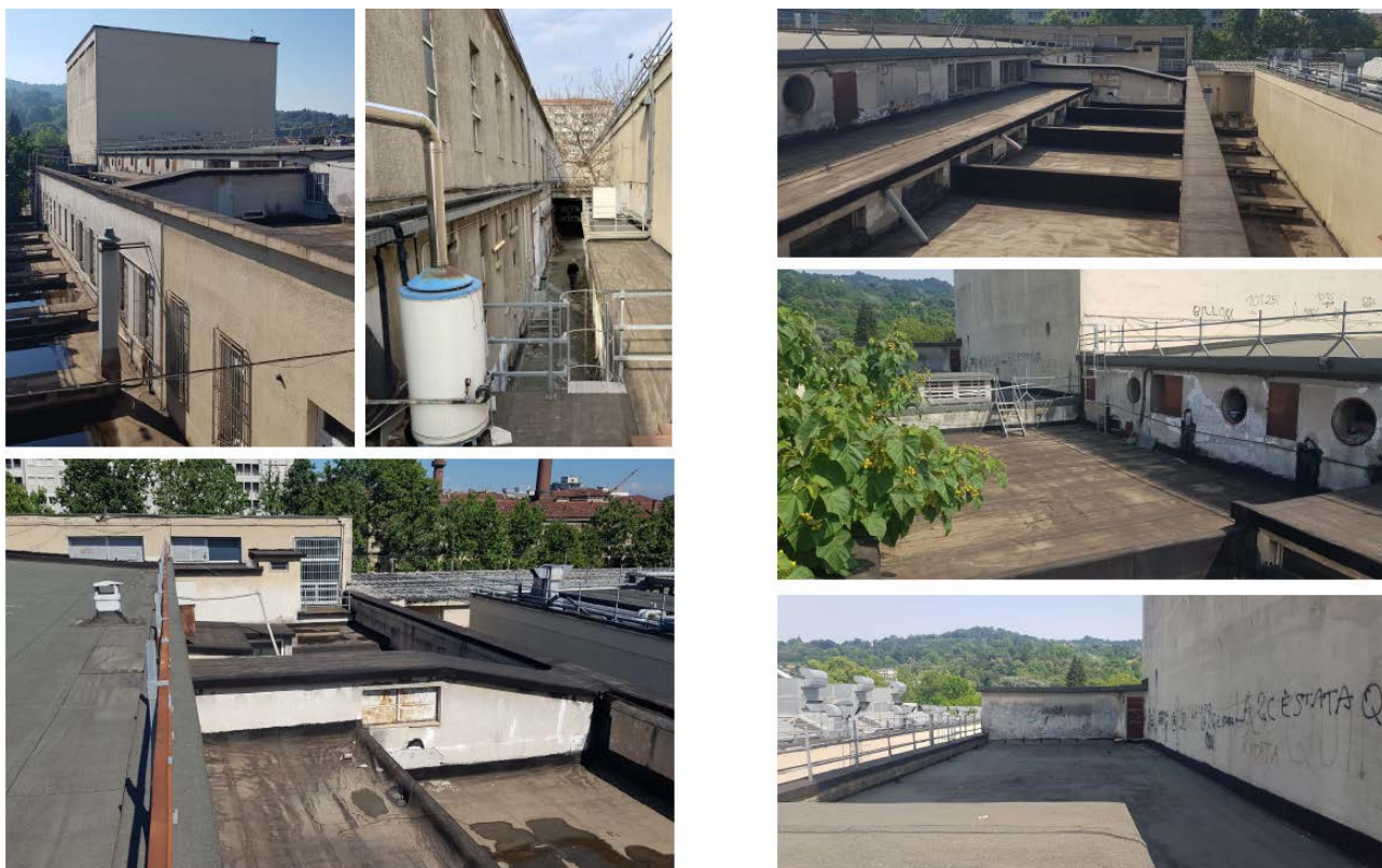
Foto dello stato di fatto: viste di dettaglio delle coperture delle maniche laterali
