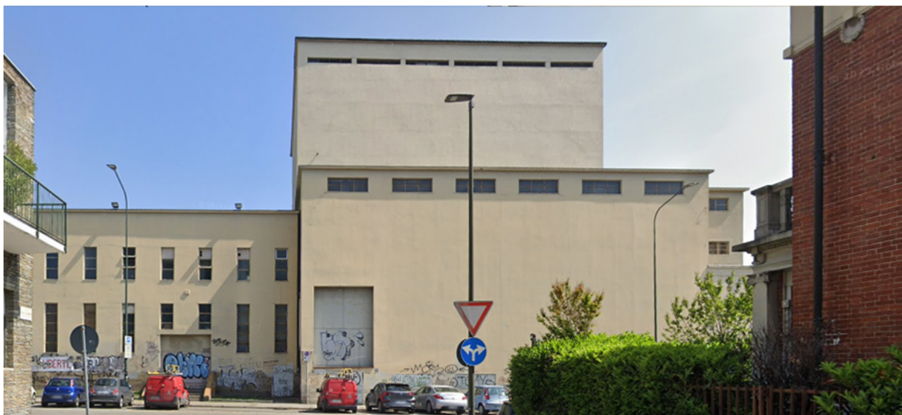
Fronte su via Petrarca- Transetto basso in cui si innesta la retrostante torre scenica molto più alta e caratterizzata dalle sottili feritoie superiori
