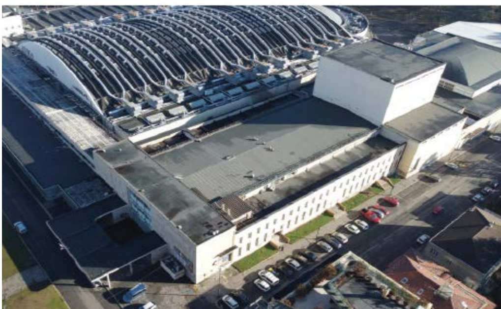
Foto dello stato di fatto dell'involucro
