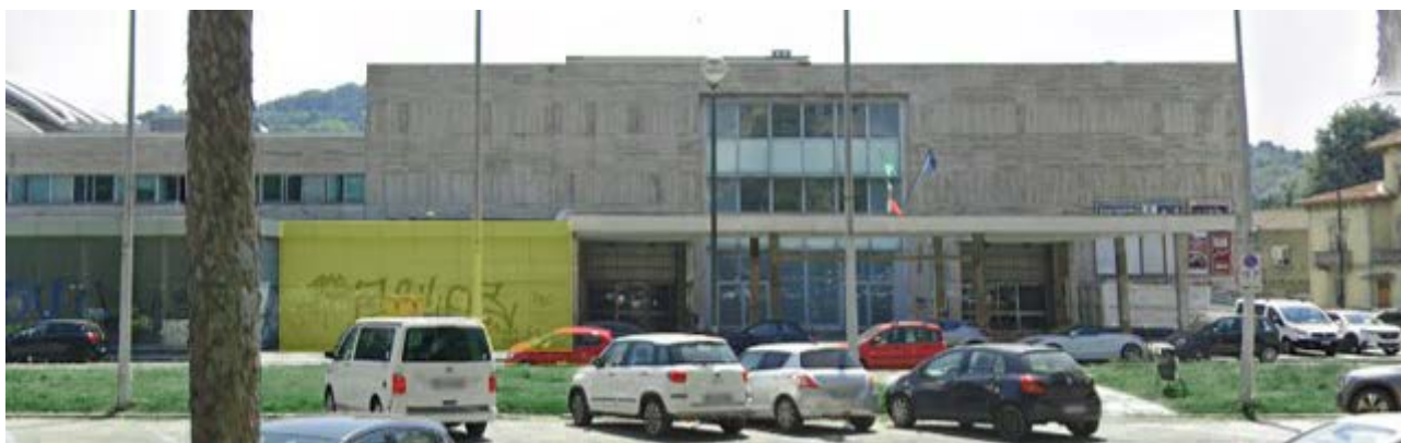
Foto dello stato di fatto del fronte su corso Massimo d'Azeglio con l'avancorpo da demolire colorato in giallo
