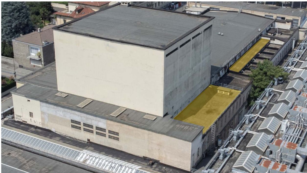
Fotografie della copertura con indicati i solai interamente demoliti
