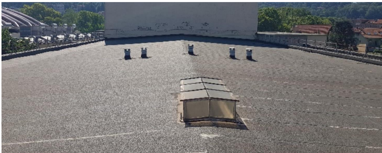
Foto 3 copertura fascia centrale dell'edificio -lucernaio esistente -collocato fra le due travi 3.70 rinvenute durante le prime demolizioni
