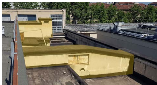
Locali in copertura da demolire lato via Petrarca
