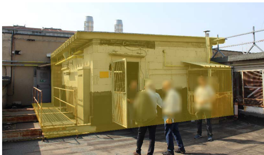
Locali in copertura da demolire lato via Petrarca
