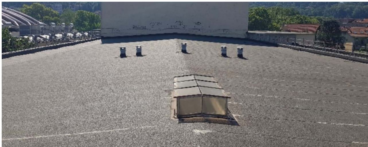
Foto copertura fascia centrale dell'edificio-con lucernaio esistente (9)
