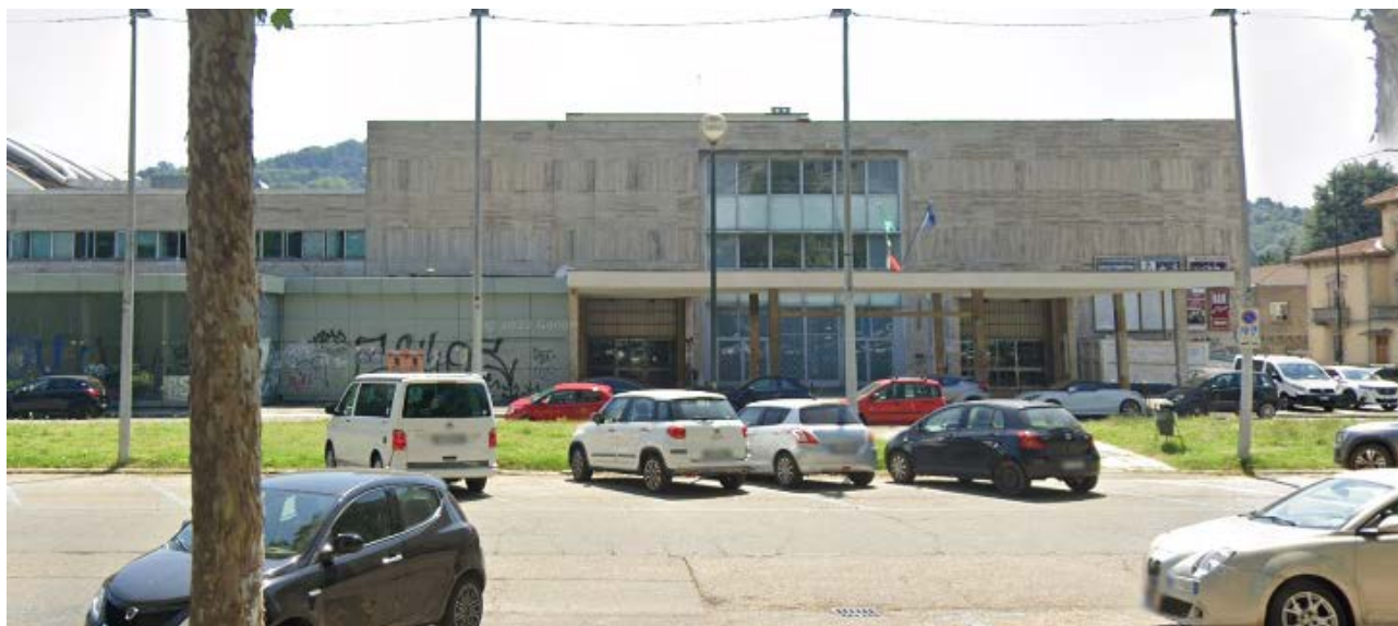
Foto dello stato di fatto del fronte su corso Massimo d'Azeglio con l'avancorpo realizzato in occasione delle Olimpiadi 2006 -demolito con l'inizio del cantiere biblioteca
