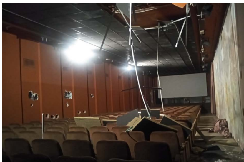
Piano terreno – Sala grande spettacoli, Sala Valentino e Sala Petrarca con evidenti crolli del controsoffitto
