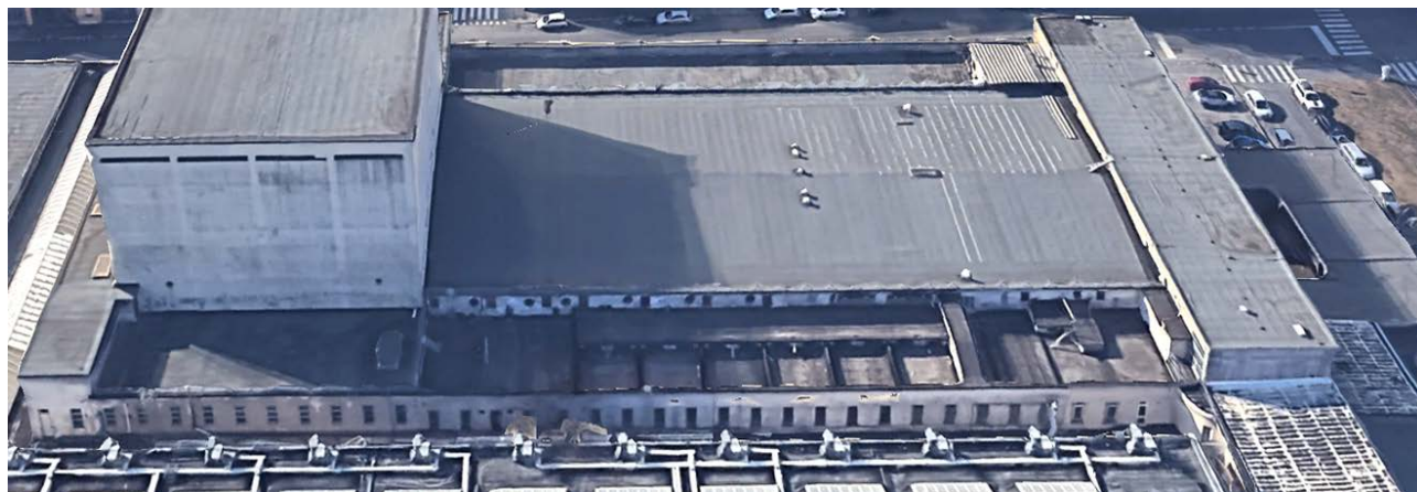
Fronte laterale verso il pad.2– Foto da drone
