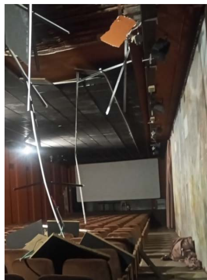
Piano terreno – Sala grande spettacoli, Sala Valentino e Sala Petrarca con evidenti crolli del controsoffitto
