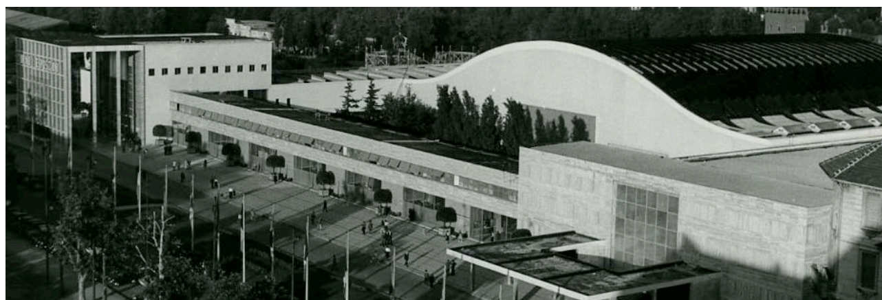
Fotografia storica degli anni 50 del fronte di corso M.d'Azeglio
