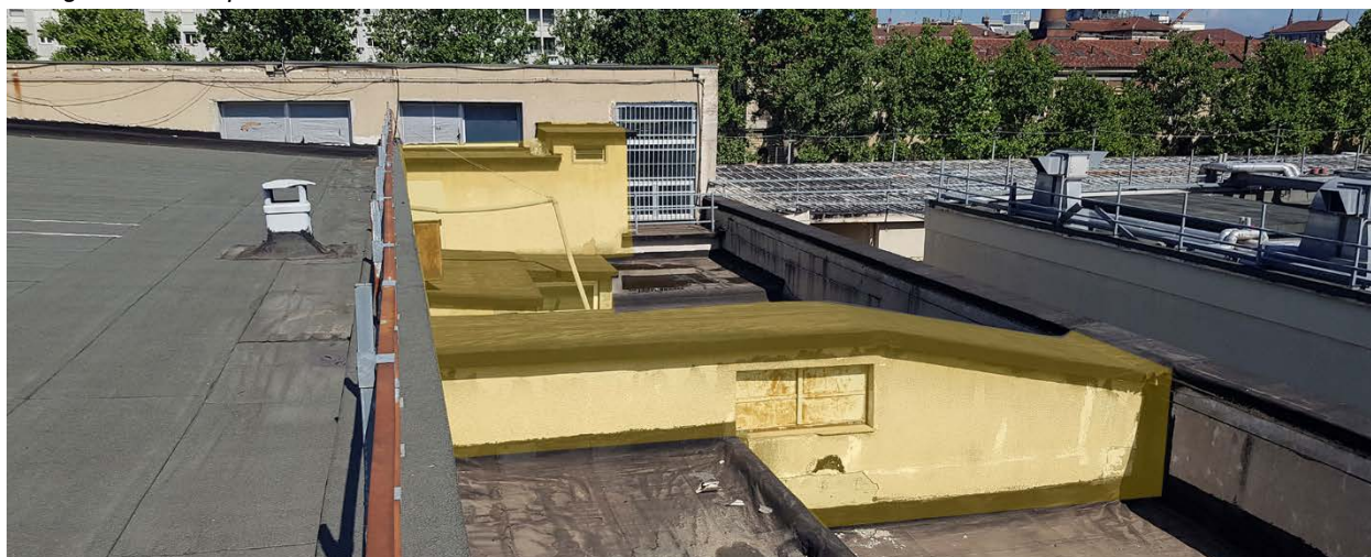
Locali in copertura da demolire verso il lato pad.2
