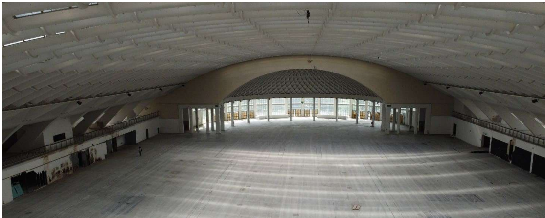
Figura 2. - Pad.2 Stato di fatto del piano terreno, con in fondo l'abside vetrato e vista delle due balconate laterali simmetriche
