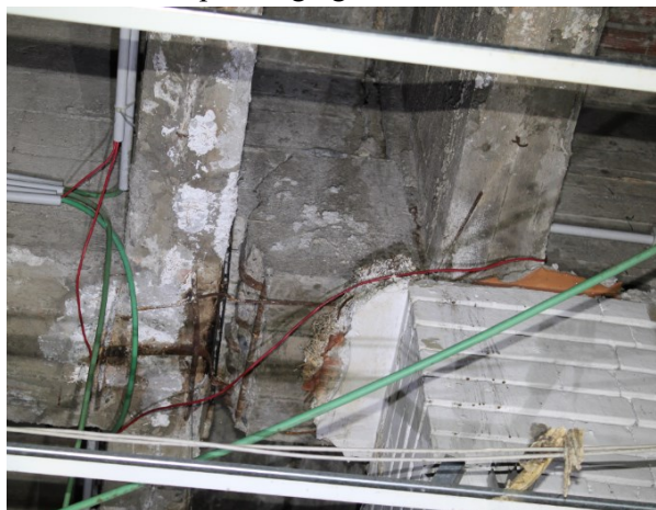
Figura 54: Vista della cerniera Gerber - Padiglione 2b.
