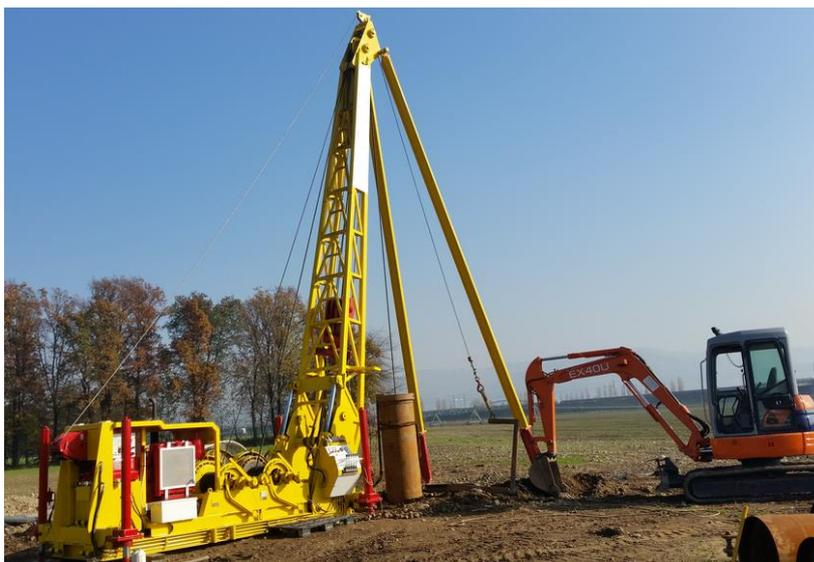
Figura 2: impianto di perforazione a percussione
