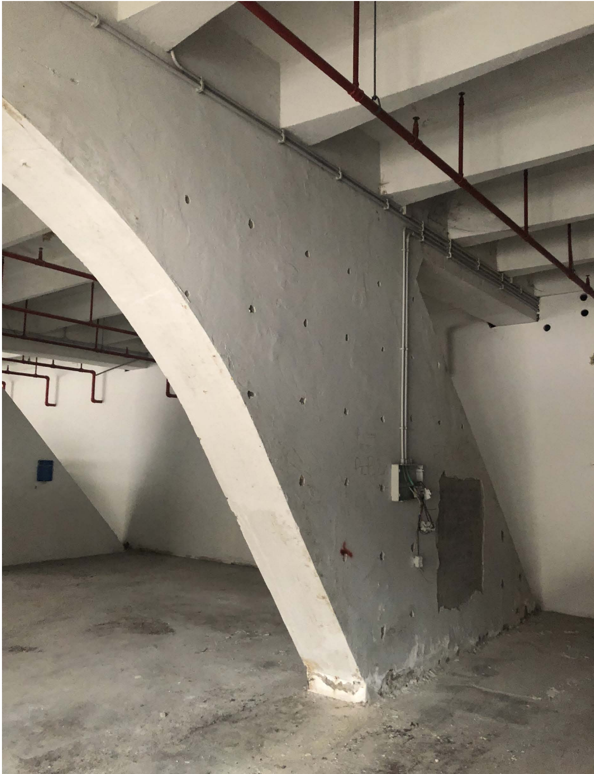
Foto 4: Pilastri struttura originaria Nervi
