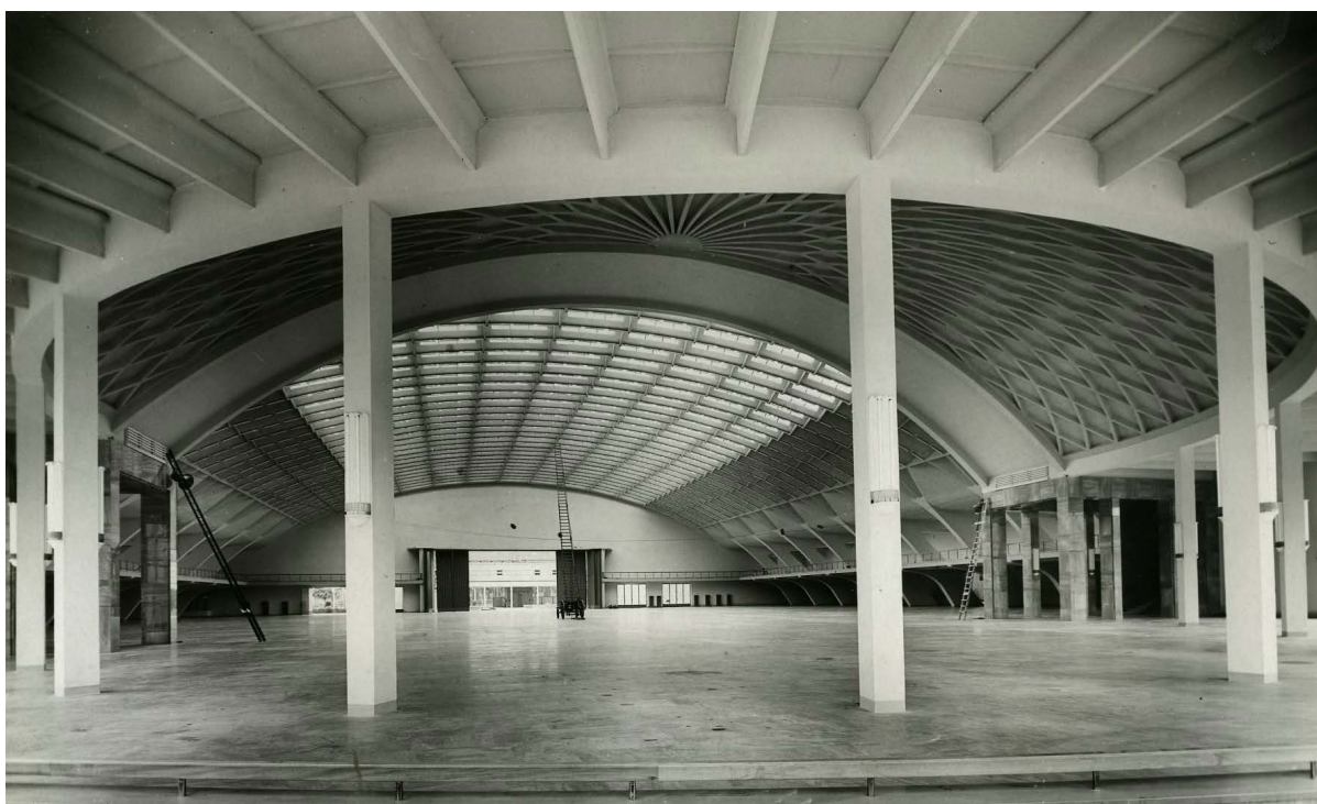
Foto 6: Vista dell'abside alla completa realizzazione
