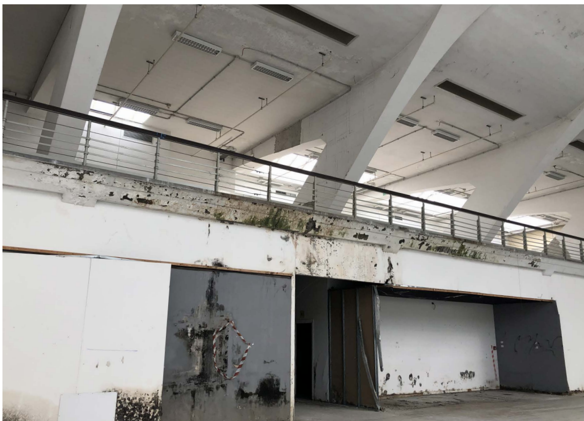
Foto 5: Vista struttura Nervi soppalchi a Sud
