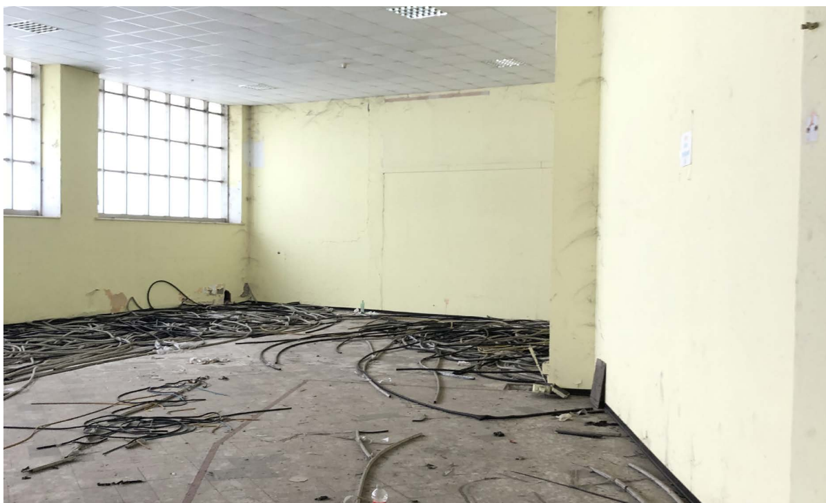
Foto 1: Vetrate stanza parte abside
