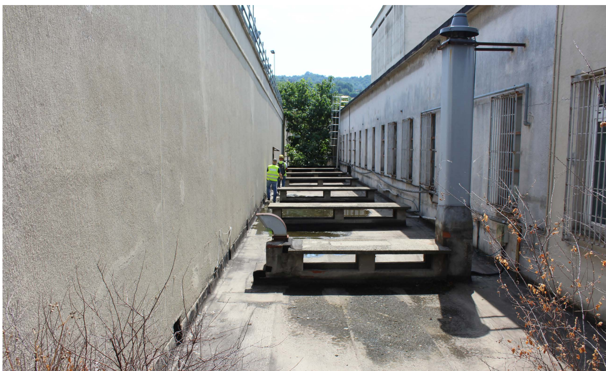
Foto 1: Porta di sicurezza verso corridoio Padiglione 2B
