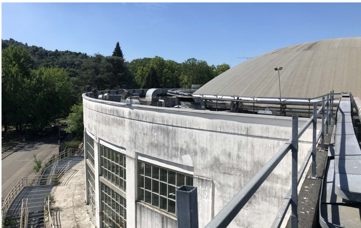
Foto 1: Vista zenitale copertura abside
