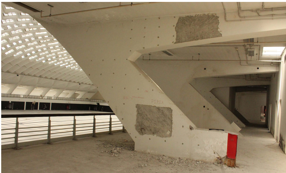
Foto 1: Pilastri strutturali seriali alla base della copertura di Nervi
