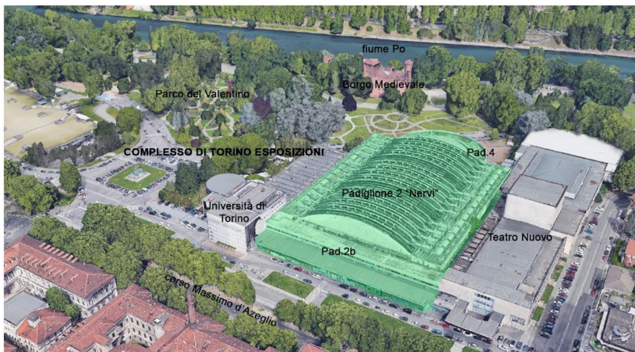
Figura 1– Vista aerea del Complesso con indicazione, in verde, degli edifici oggetto di intervento.
