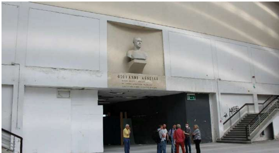
Foto del Pad.2 verso ingresso. Ai lati del busto del senatore Agnelli verranno ripristinate le aperture vetrate
