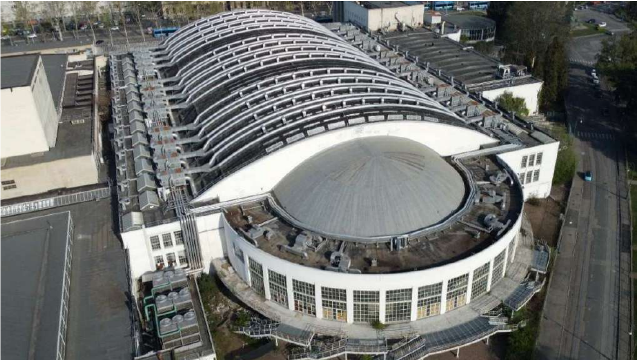
Padiglione 2 - Stato di fatto delle coperture
