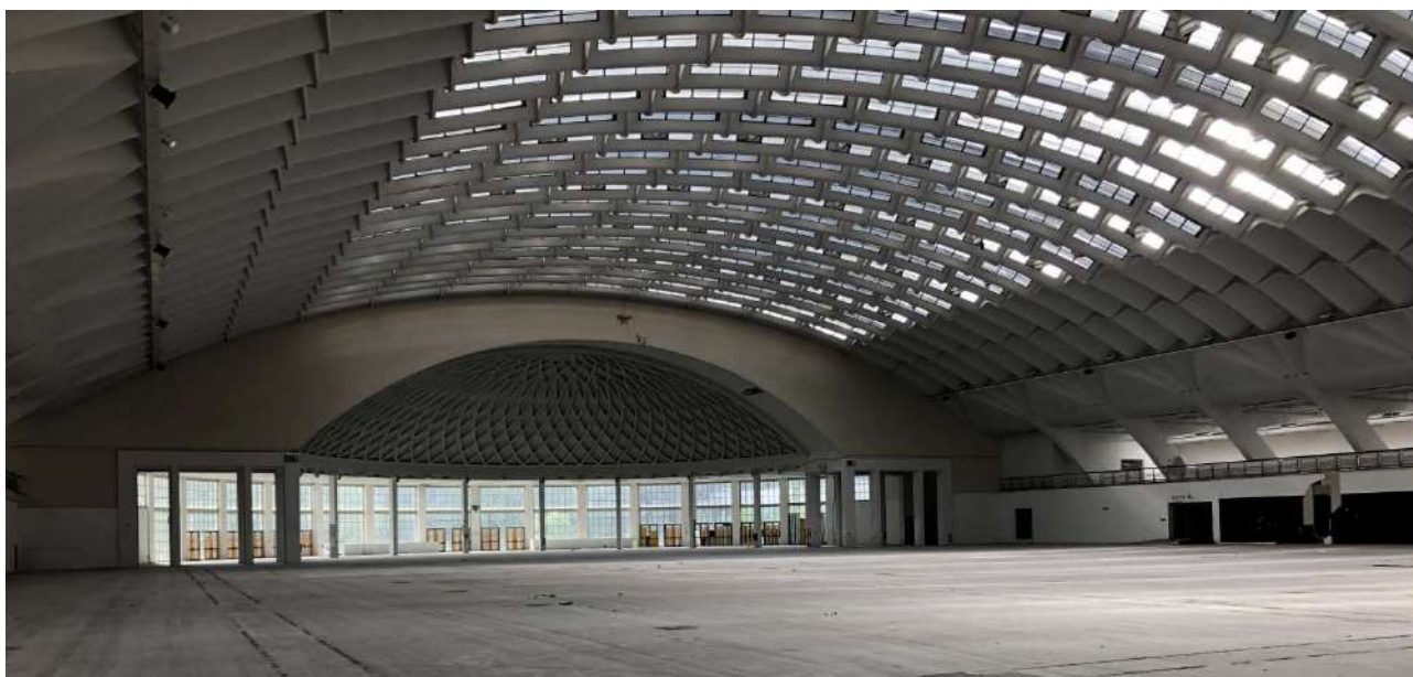
Stato di fatto - Padiglione 2, vista del salone dall'ingresso principale su c.so Massimo d'Azeglio
