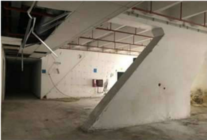
Stato di fatto - viste interne del padiglione 2, rispettivamente frontone interno lato corso Massimo da balconata sud, locali piano terra sotto balconata, vano tecnico al piano terra sotto balconata
