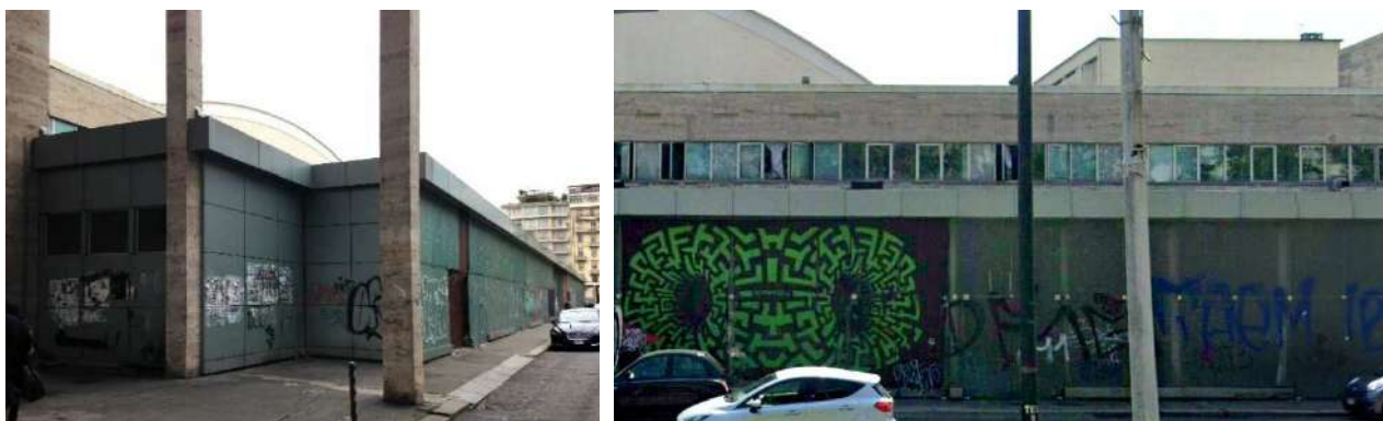
Viste da c.so Massimo d'Azeglio. Avancorpo (1963/2006) e finestratura piano primo
