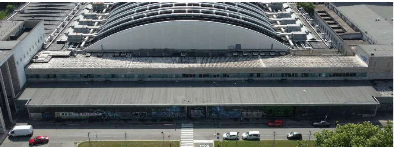
Padiglione 2b ed avancorpo – Vista dall'alto della copertura
