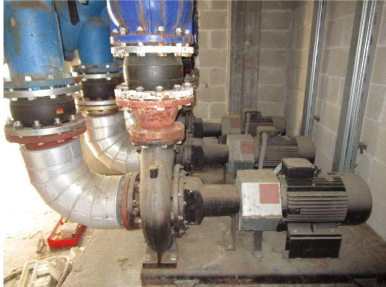
*Figura 3: Pompaggi acqua calda*
