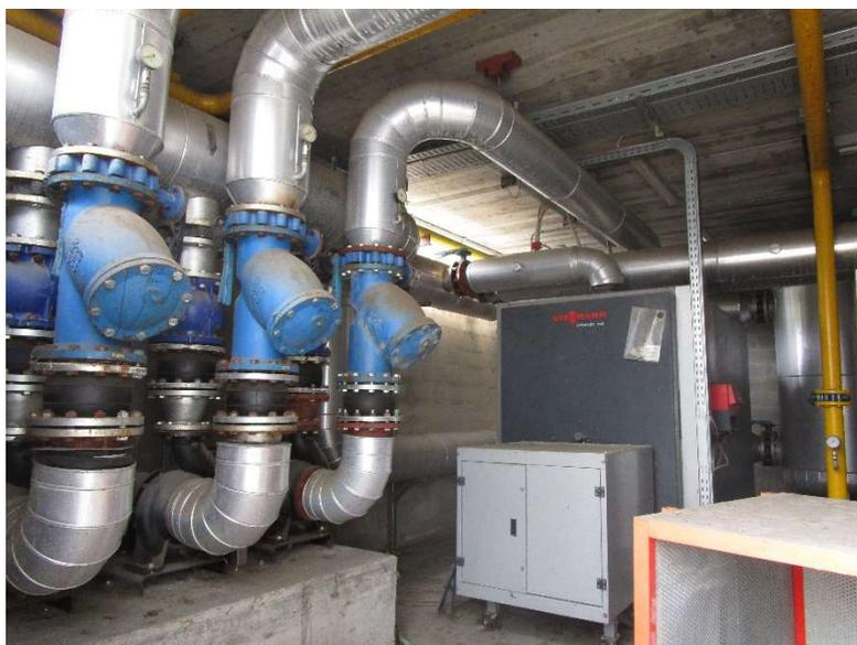
Figura 2: Caldaia e collettori
