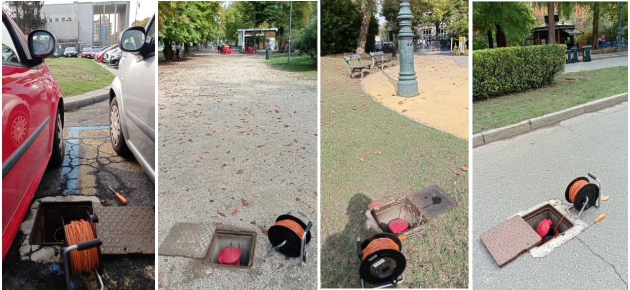
Figura 31: rete piezometrica Politecnico di Torino – Padiglione V. Da sx. a dx: P1, P3, P4, P8. Fonte: Anna Rosa Sannino, 2020, Politecnico di Torino. Relatore Prof. T. Tosco: “Effetto di eventi di piena sull’interazione tra acquifero e corso d’acqua: simulazione della falda superficiale nell’area metropolitana di Torino”
