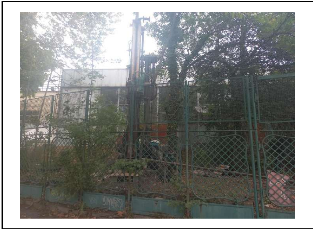
Foto 27: Postazione sondaggio S4.
