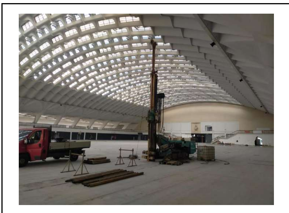
Foto 18: Postazione sondaggio S3.
