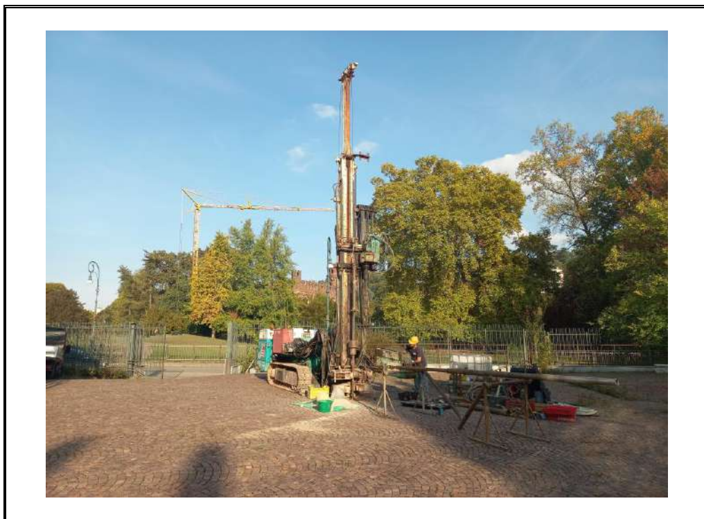
Foto 32: Postazione sondaggio S5.
