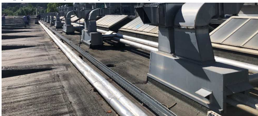
Fotografia dello stato di fatto della copertura pad.2 con gli impianti da smantellare e le parti laterali piane
