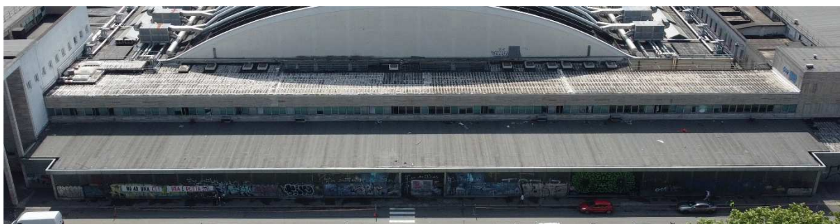
Padiglione 2b ed avancorpo - Copertura
