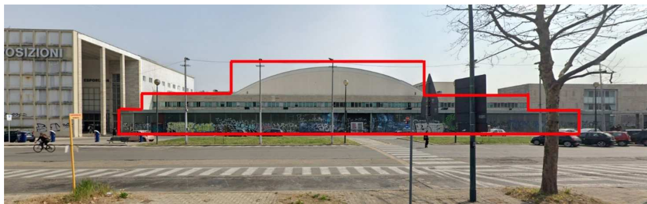
Fronte di intervento su corso Massimo d'Azeglio.
