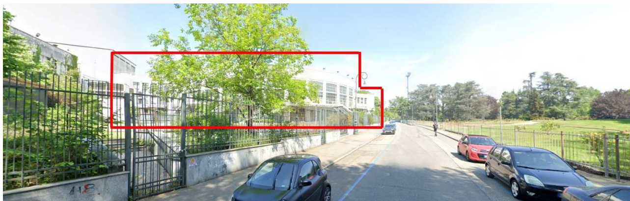
Fronte di intervento da viale Boiardo arrivando dal fiume nel senso della salita
