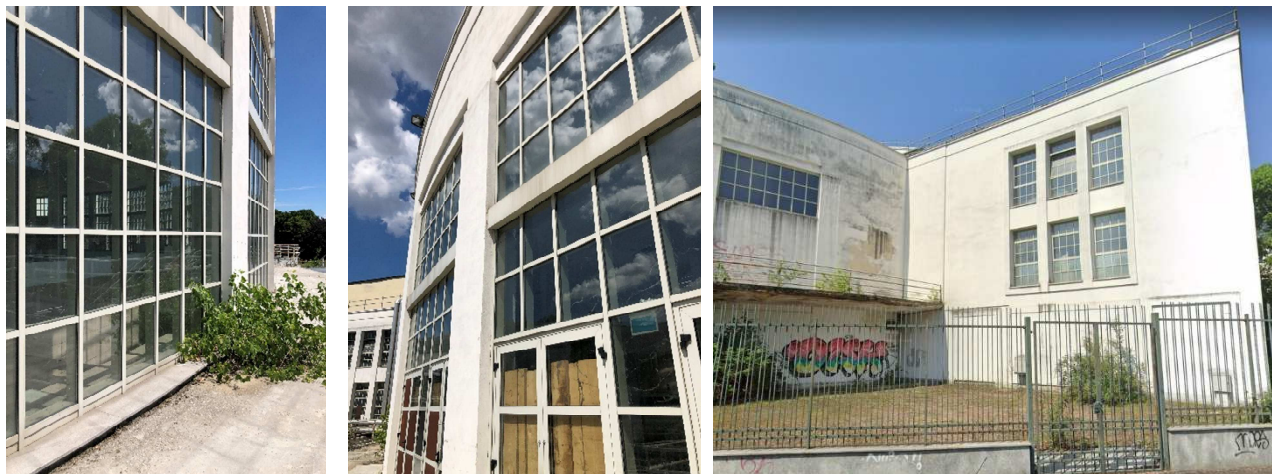
Foto dello stato di fatto: vetrata abside e facciata in cui sarà aperto il varco
