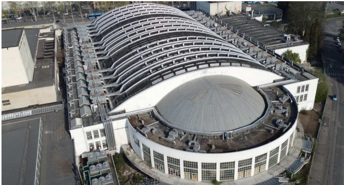
Padiglione 2 - Stato di fatto delle coperture
