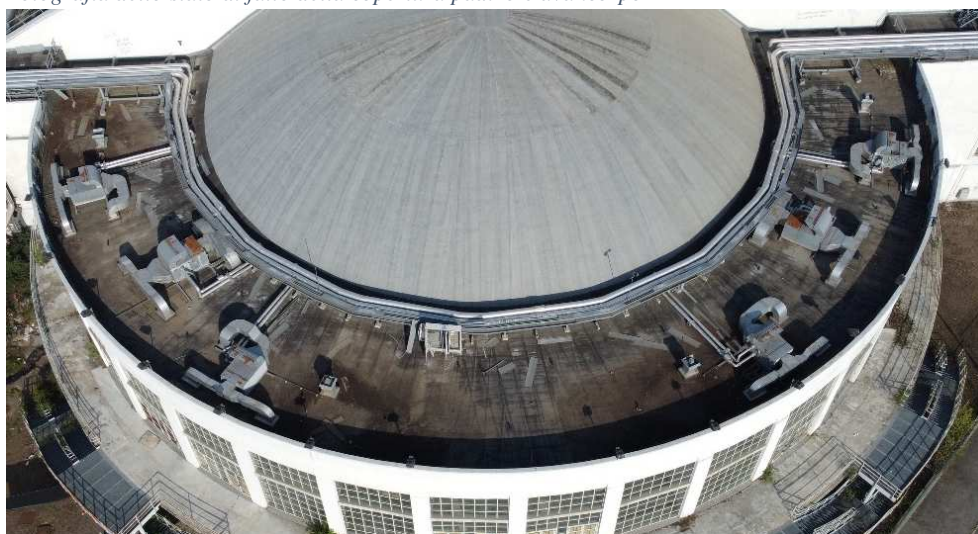
Fotografia dello stato di fatto della copertura dell'abside pad.2
