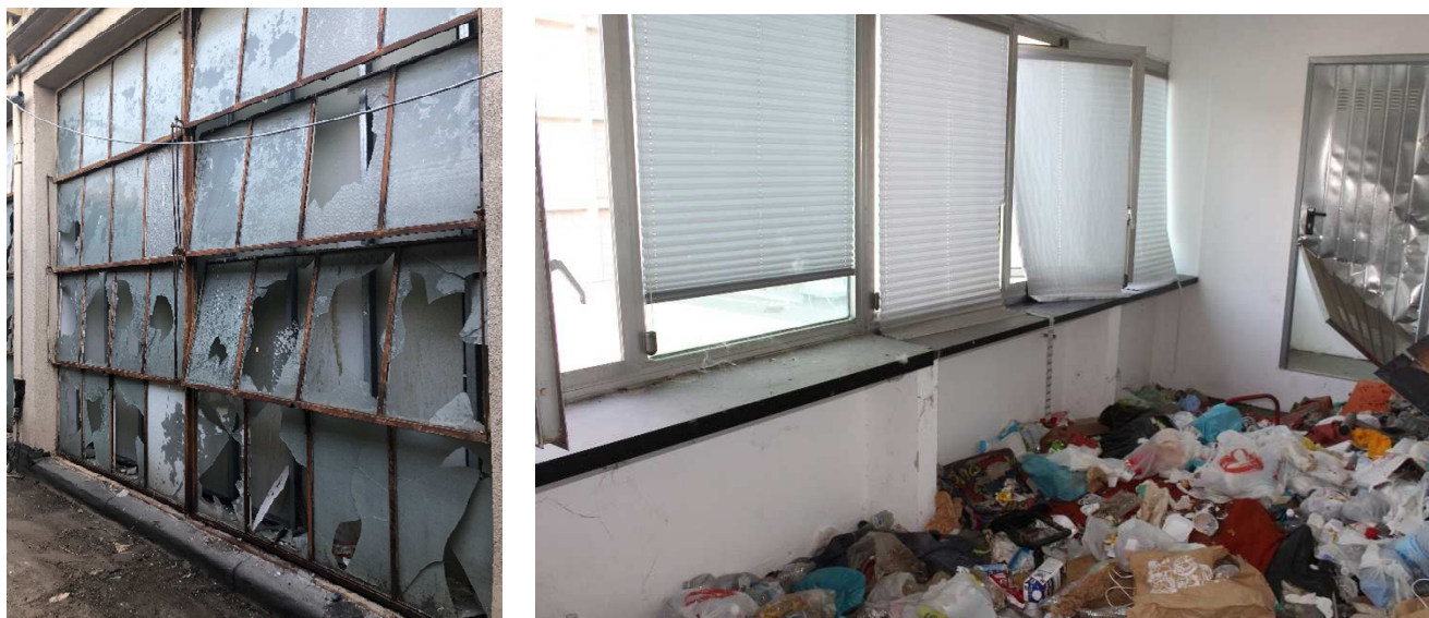
Fotografia dello stato di fatto dei serramenti pad.2b piano primo
