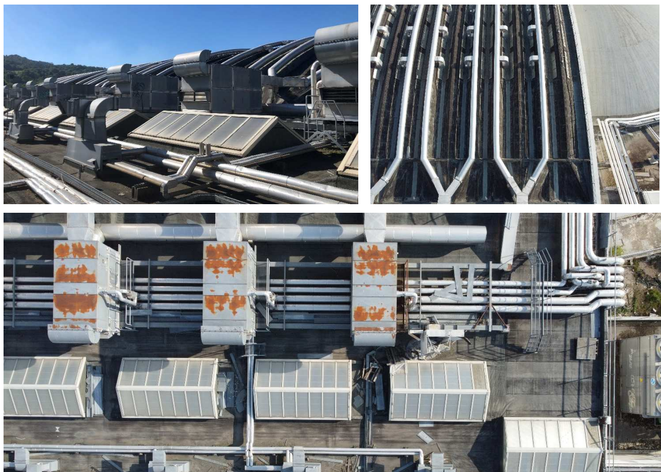
Fotografie della copertura del pad.2
