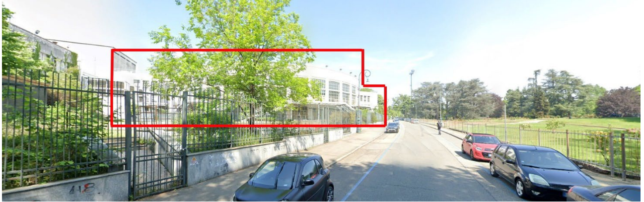
Fronte di intervento da viale Boiardo arrivando dal fiume nel senso della salita
