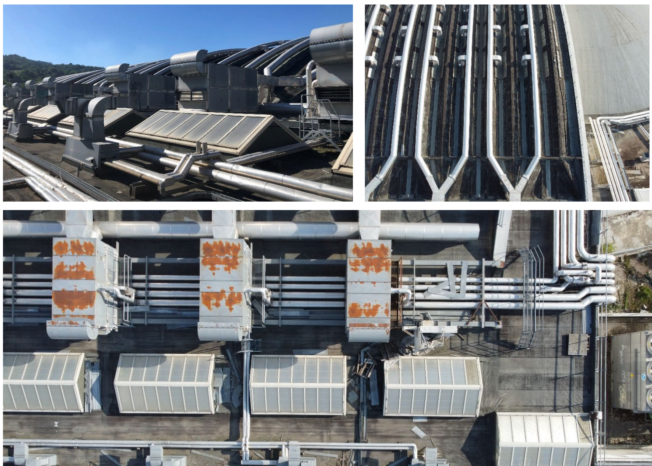
Fotografie della copertura del pad.2
