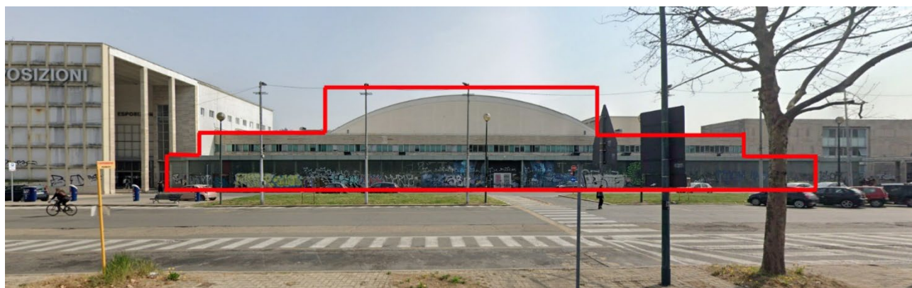
Fronte di intervento su corso Massimo d'Azeglio.
