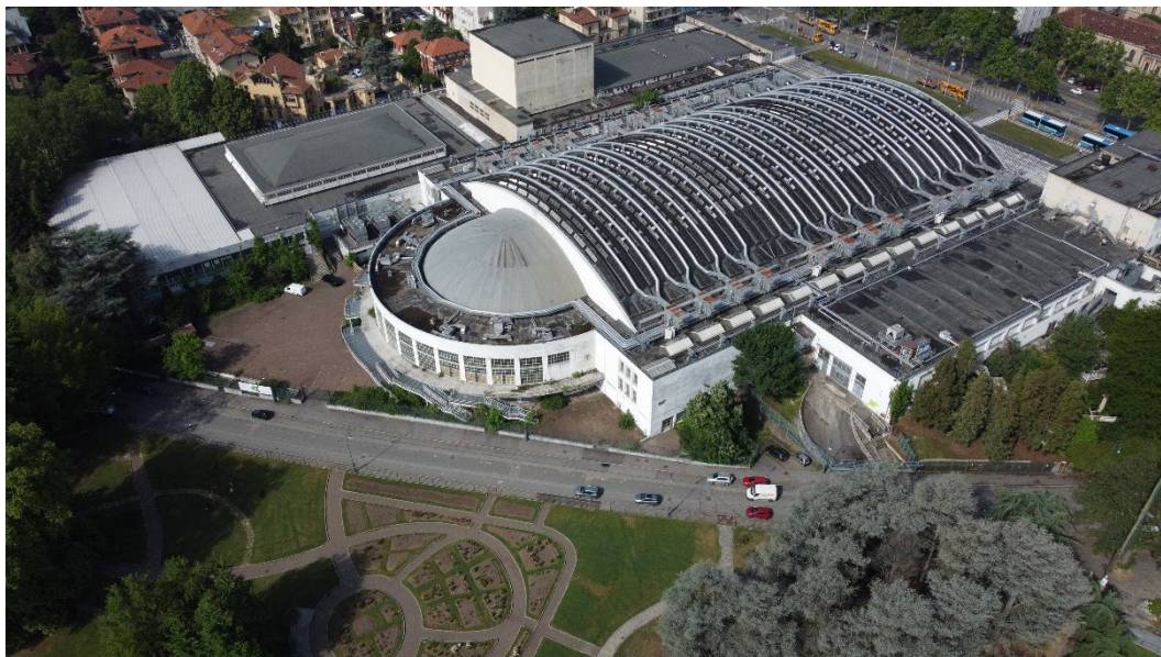
Fotografia realizzata da drone, dal lato fiume verso sud
