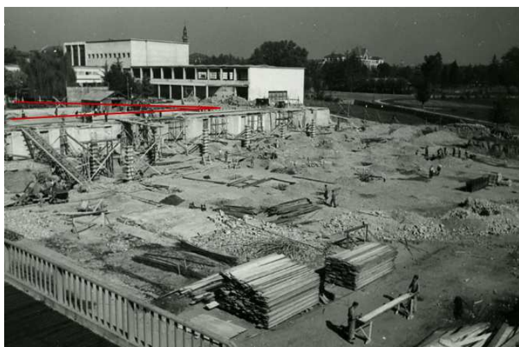
Figura 11 – Il cantiere Nervi ripreso da SE
