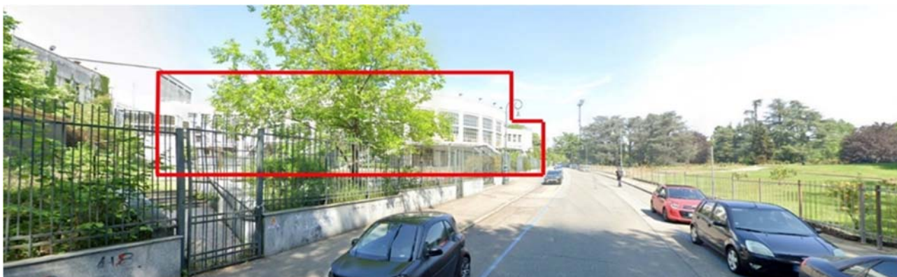
Figura 38 - Fronte di intervento da viale Boiardo arrivando dal fiume nel senso della salita
