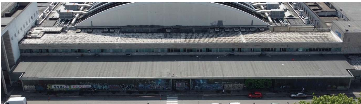
Figura 13 – Padiglione 2b ed avancorpo – Vista dall'alto della copertura
