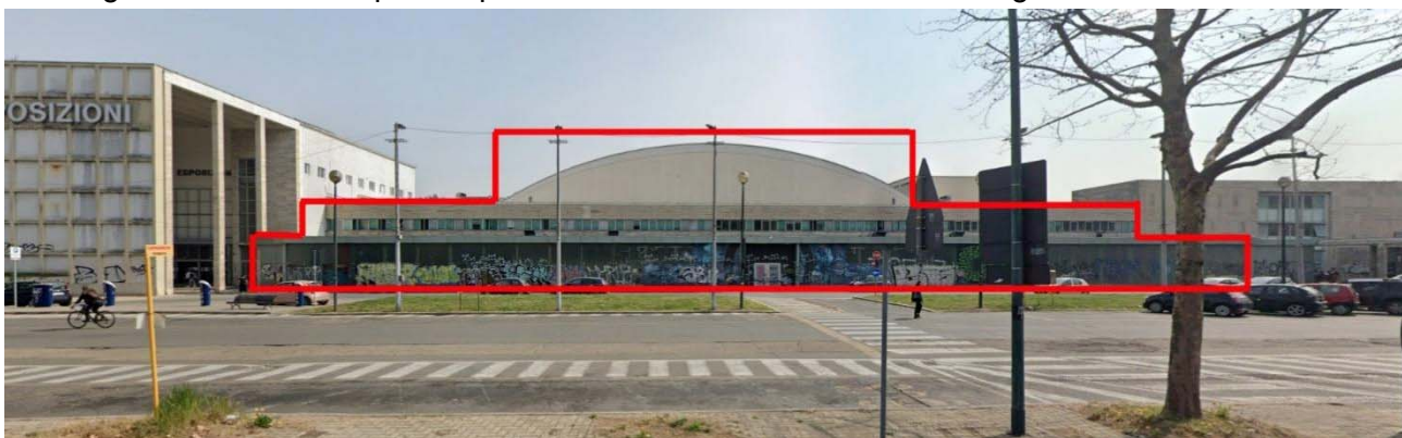
Figura 37 - Fronte di intervento su corso Massimo d'Azeglio.
