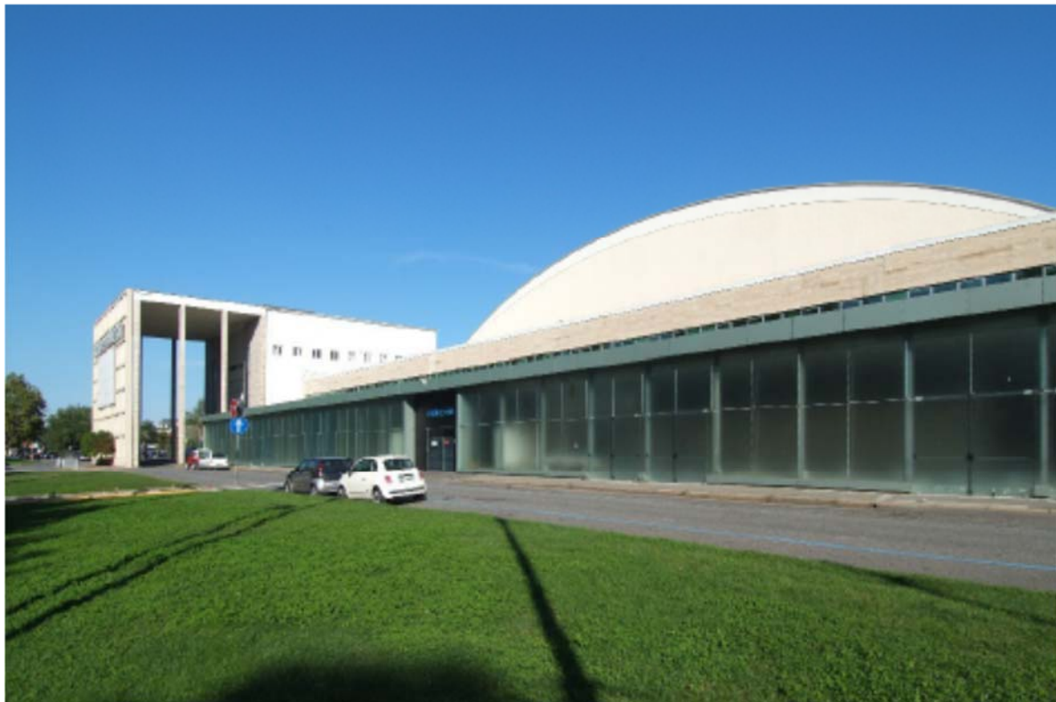
Foto 2_ prima la demolizione dell'avancorpo
