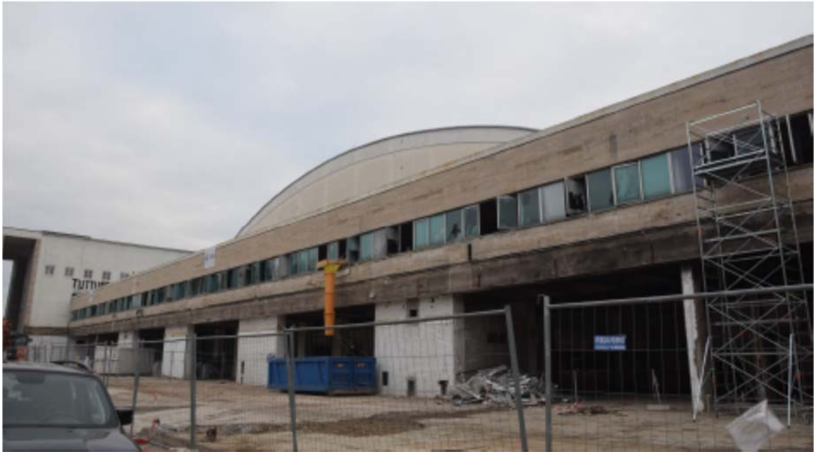
Foto 1_ dopo la demolizione dell'avancorpo
