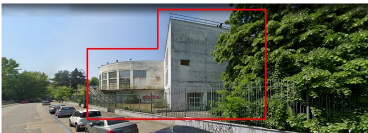
Figura 39 - Fronte di Nord Est da viale Boiardo scendendo verso il fiume
