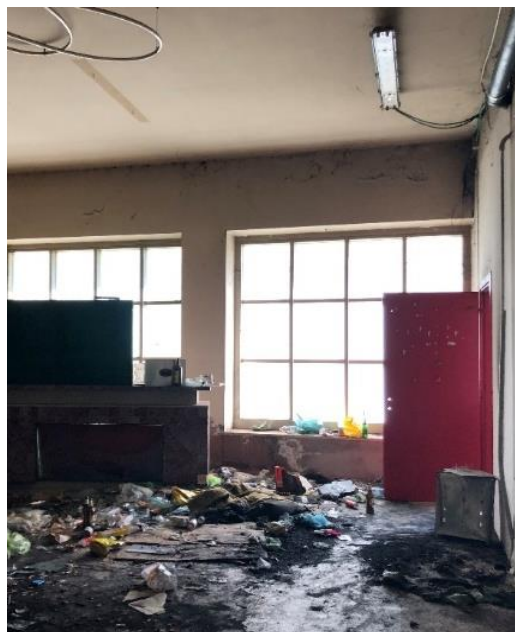
Figura 16 – Stato di fatto – Padiglione 4 piano interrato, rispettivamente sala abside e locale bar su fronte viale Boiardo
