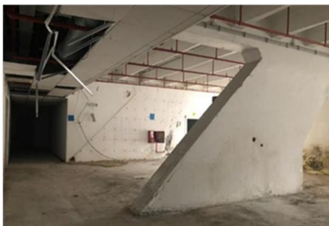
Figura 15 – Stato di fatto - viste interne del padiglione 2, rispettivamente frontone interno lato corso Massimo da balconata sud, locali piano terra sotto balconata, vano tecnico al piano terra sotto balconata
