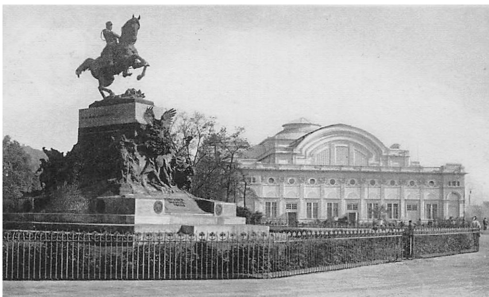
Figura 3 - Il palazzo del Giornale, fronte verso corso Massimo d'Azeglio
