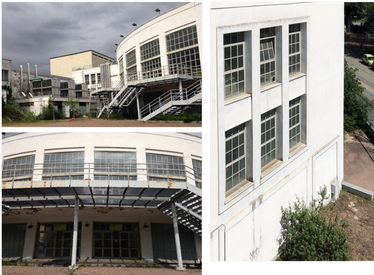
Figura 55 - Viste della facciata del padiglione 2 verso il Parco
