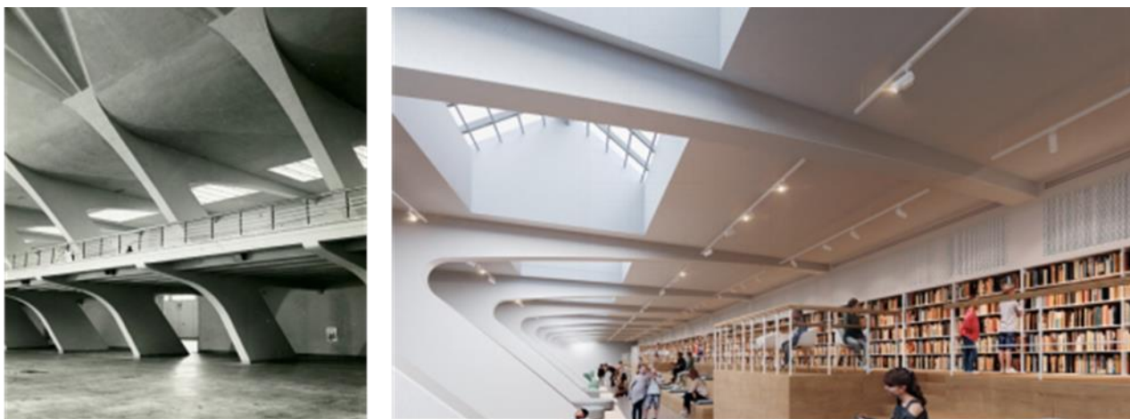
Foto storica dell'interno del salone, in cui sono evidenti proiettori collocati nel centro delle campate sotto la balconata del piano primo e vista renderizzata di progetto dei soppalchi con i 3 binari paralleli
