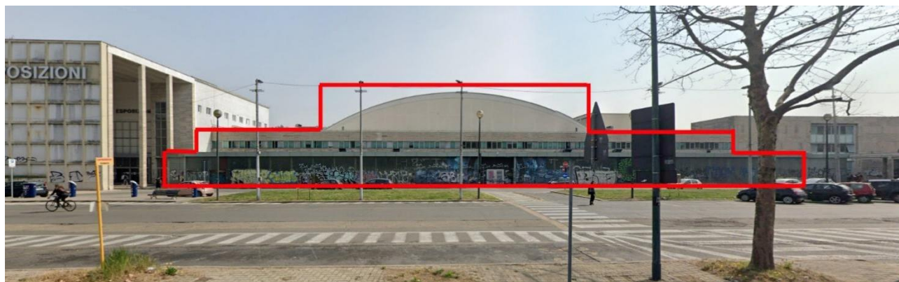
Figura 50 - Fronte di intervento su corso Massimo d'Azeglio.
