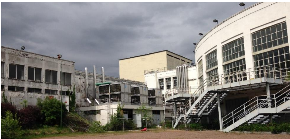
Figura 11 - Vista della facciata del Padiglione 2 verso il Parco
