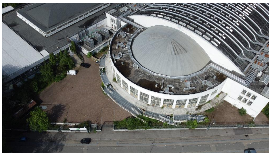
Foto dal drone del cortile dal lato del Parco, con in basso viale Boiardo.
