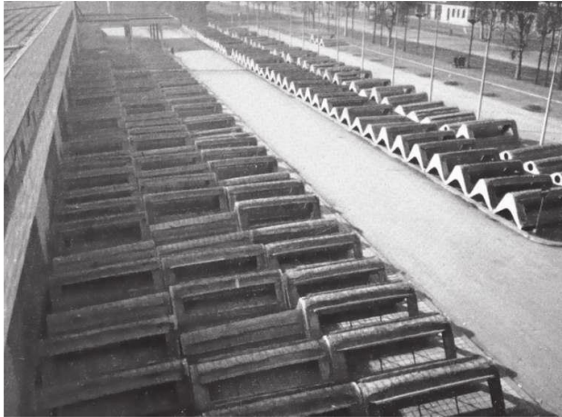
Figura 50 - Padiglione 2, stoccaggio dei conci prefabbricati
