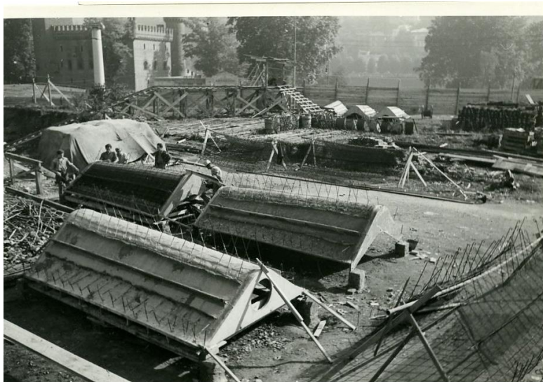
Figura 59 - Elementi in ferroceemento della volta ondulata prefabbricati in opera.
