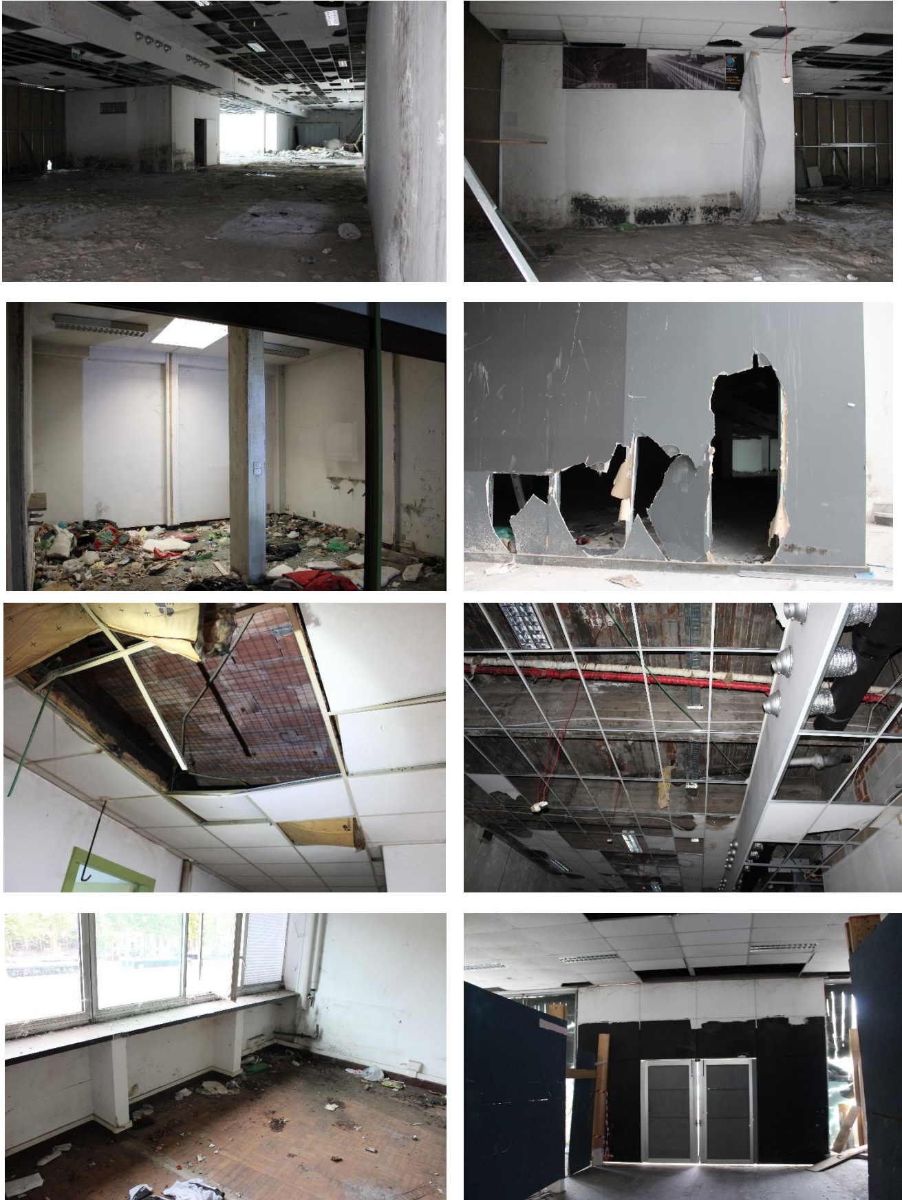
Figura 32 - Padiglione 2b - Fotografie dello stato di fatto dei locali interni
