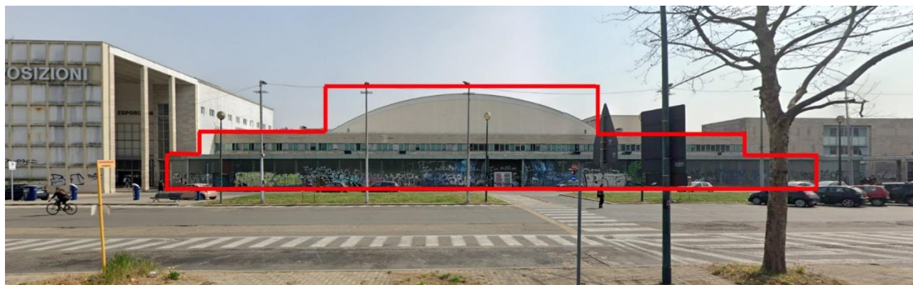
Figura 22 – Fronte di intervento su corso Massimo d'Azeglio.
