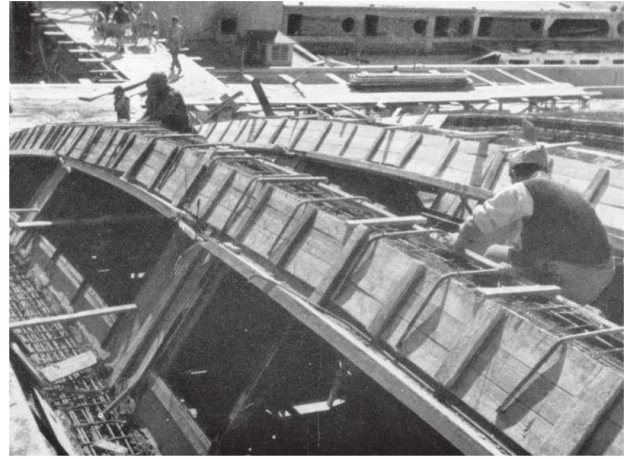
Figura 51- Padiglione 2, immagine di cantiere
