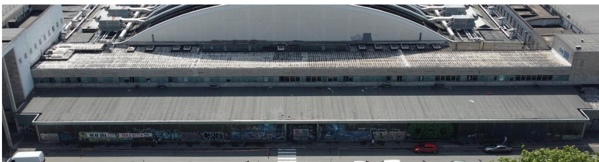
Figura 28 –Padiglione 2b ed avancorpo - Copertura
