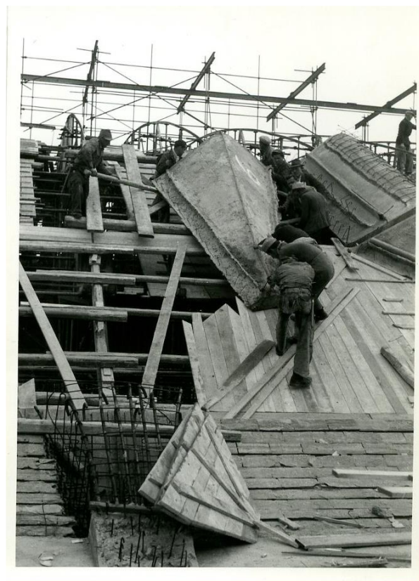
Figura 14: Posa in opera degli elementi in ferrocemento del ventaglio.
