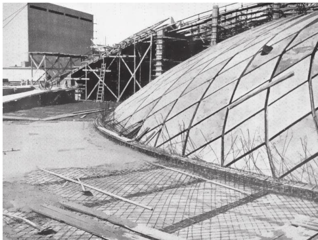
Figura 56 - Padiglione 2, immagine di cantiere
