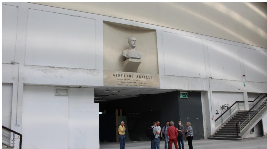
Foto del pad.2 verso ingresso. Ai lati del busto verranno ripristinate le aperture vetrate.
