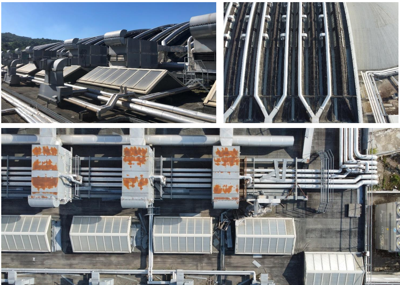
Fotografie della copertura del pad.2
