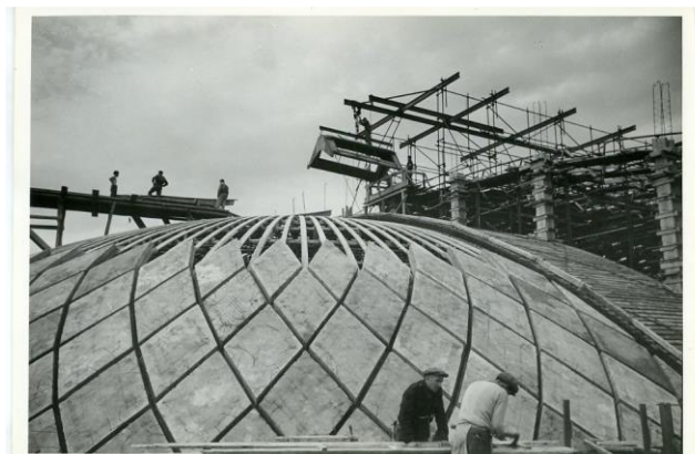
Figura 25: Semicupola in costruzione, (Nervi, Le strutture portanti del Palazzo per le Esposizioni al Valentino 1948)
