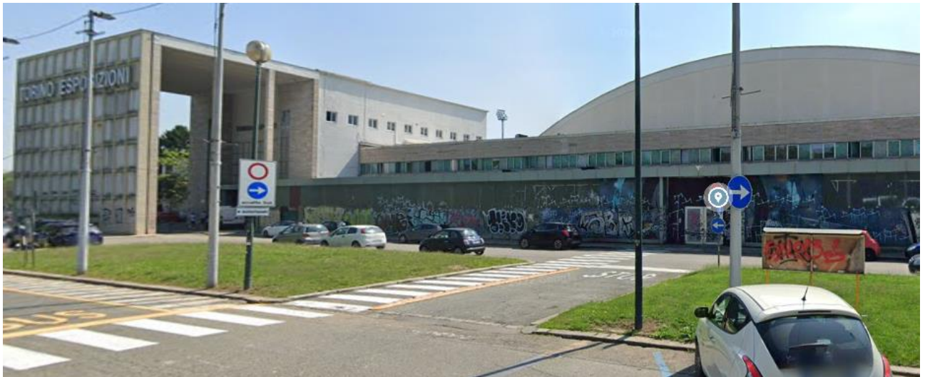
Figura 67 - Ingresso all'area di cantiere 01 dal controviale di C.so Massimo d'Azeglio
